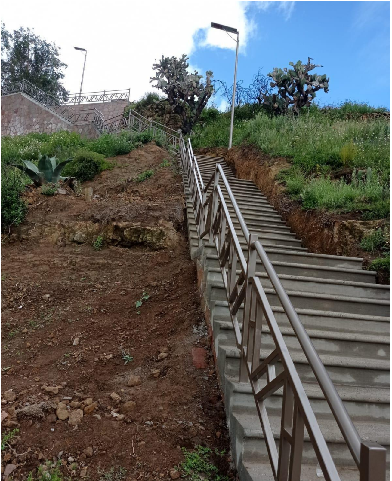
Imagen 47: Escalera Terminada. Fuente: Propia.
