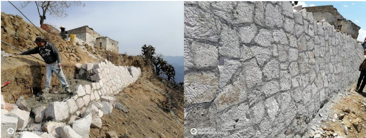
Imagen 14: Construcción de muro. Fuente: Propia.
