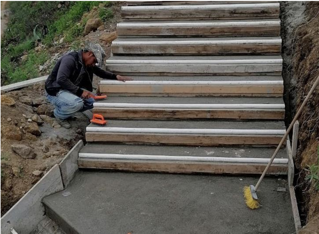
Imagen 21: Detalle de escalera. Fuente: Propia.
