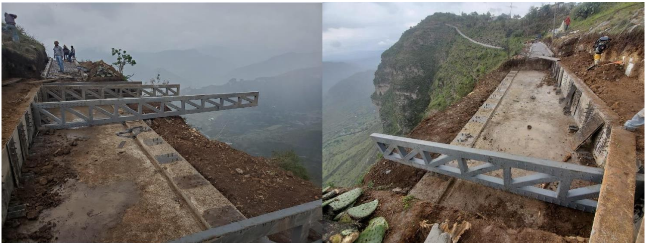
Imagen 36: Colocación de Armaduras. Fuente: Propia.
