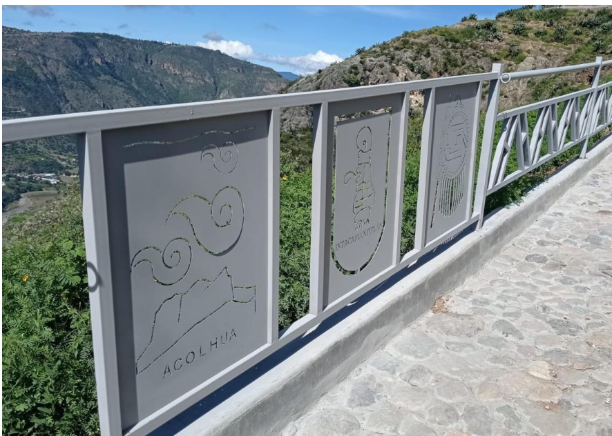
Imagen 41: Colocación Barandal. Fuente: Propia
