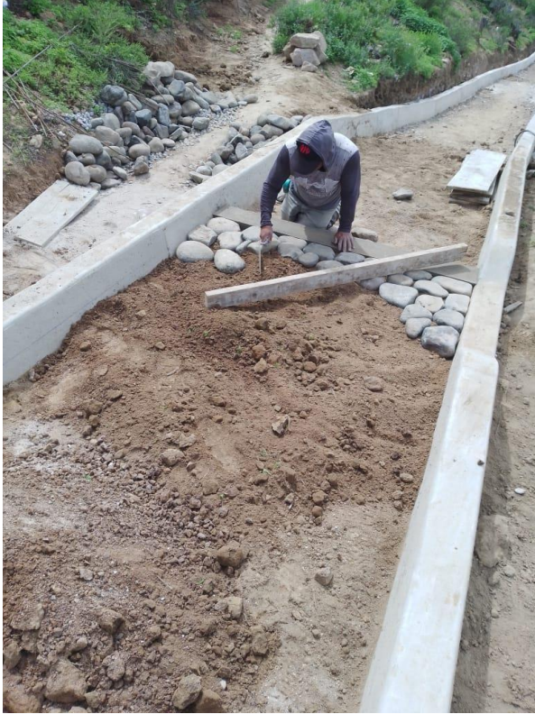
Imagen 9: Construcción de empedrado. Fuente: Propia.
