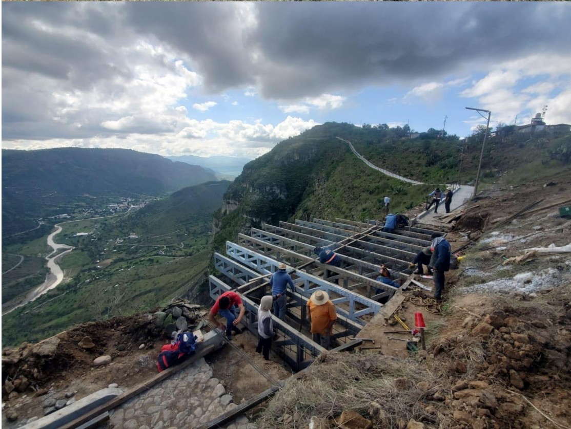
Imagen 37: Termino de colocación de estructura para mirador. Fuente: Propia.
