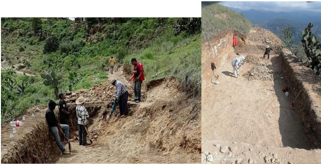
Imagen 26: Excavación con rotomartillo. Fuente: Propia.
