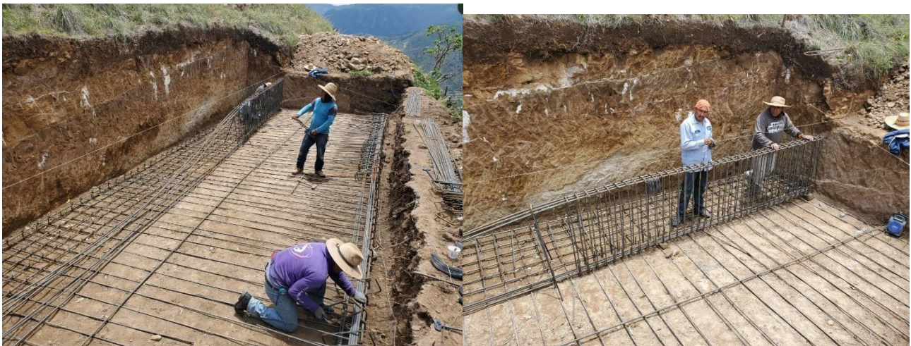
Imagen 30: Armado de muro soporte. Fuente: Propia.
