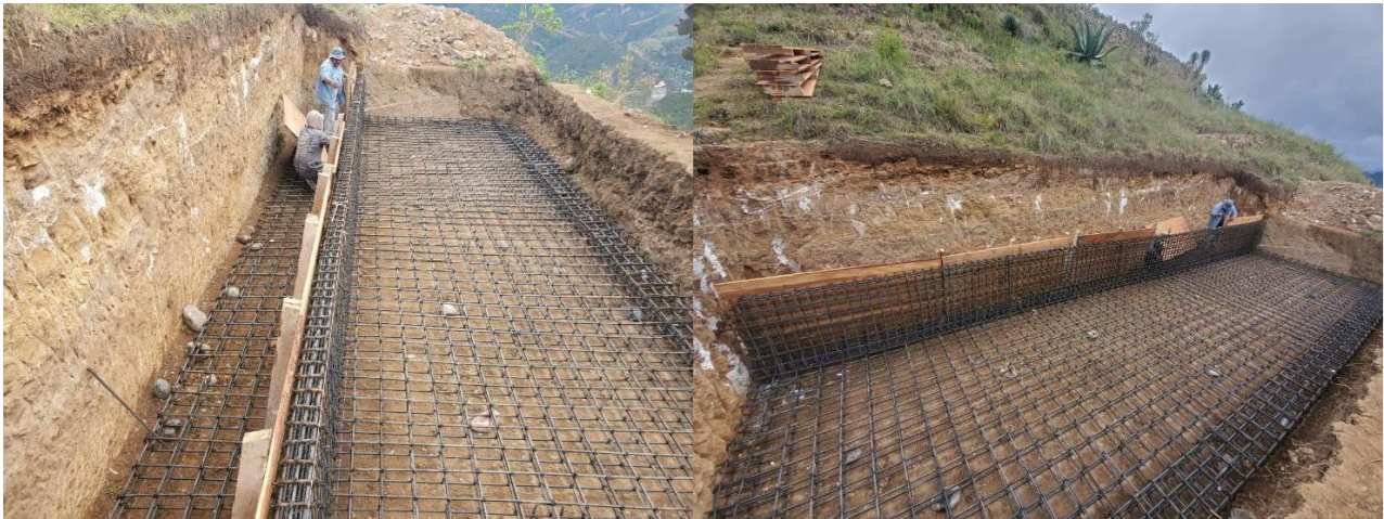
Imagen 32: Colocación de cimbra a losa de cimentación. Fuente: Propia.
