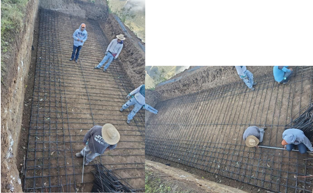
Imagen 29: Armado de losa de Cimentación. Fuente: Propia
