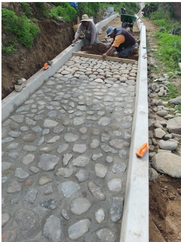
Imagen 24: Colocación de piedra bola en andador. Fuente: Propia.
