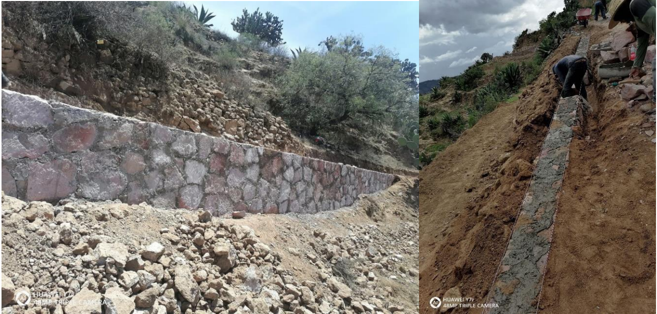
Imagen 18: Construcción de muro en andador. Fuente: Propia.
