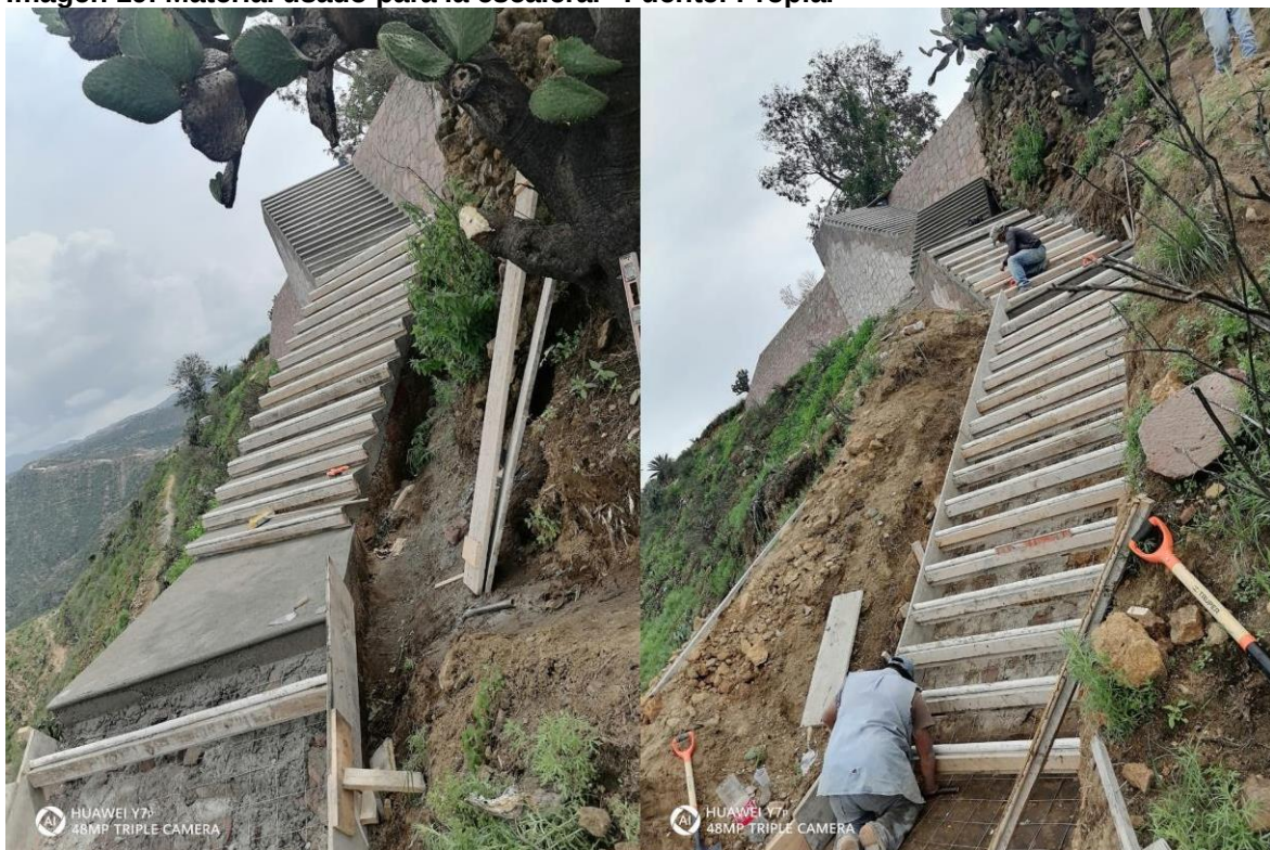
Imagen 20: Cimbra para escalera. Fuente: Propia.
