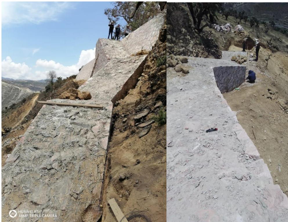
Imagen 16: Cimiento terminado de escalera. Fuente: Propia.
