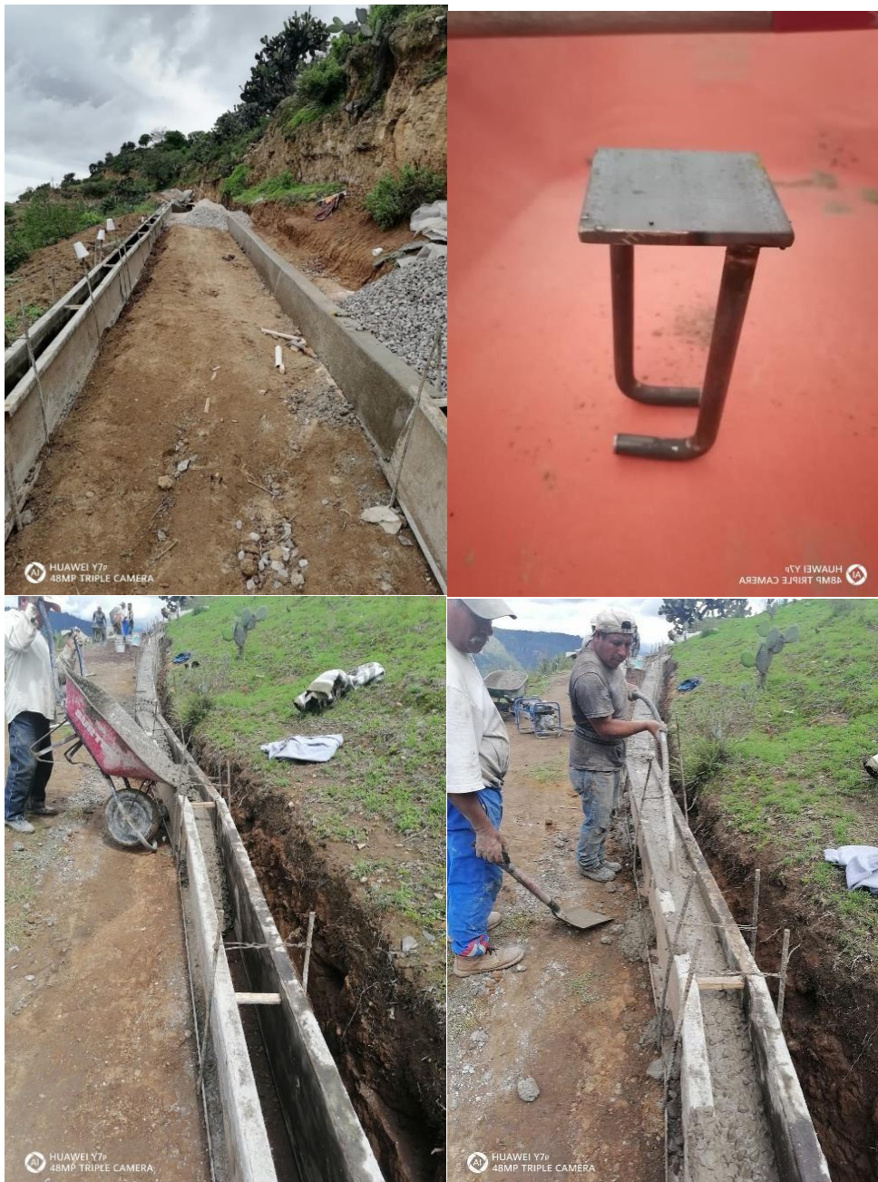
Imagen 22: Construcción de guarnición y placa para soldar tubo para barandal. Fuente: Propia
