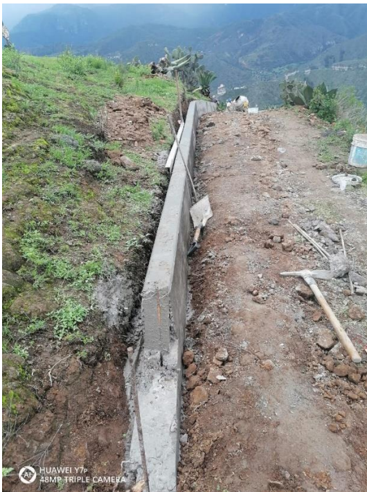
Imagen 8: Construcción de guarniciones. Fuente: Propia.
