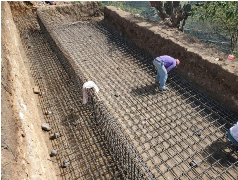
Imagen 31: Armado final de losa de Cimentación. Fuente: Propia.
