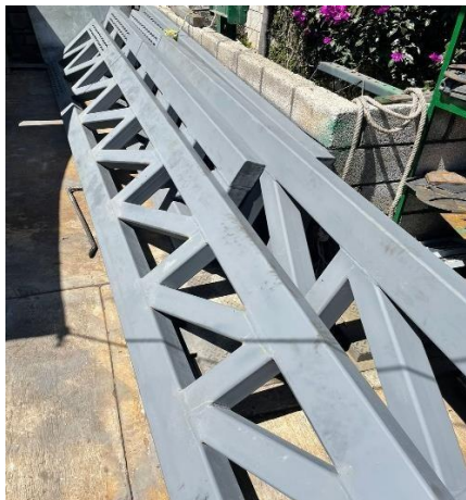
Imagen 28: Armadura para estructura de mirador. Fuente: Contratista
