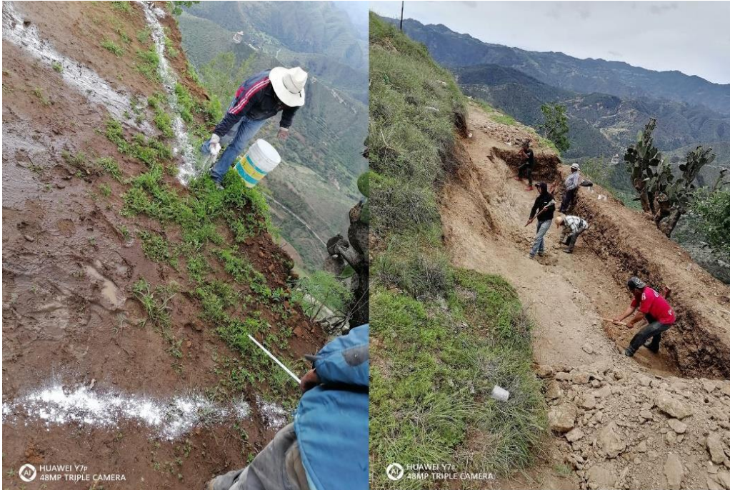
Imagen 25: Excavación para cimentación de mirador. Fuente: Propia.
