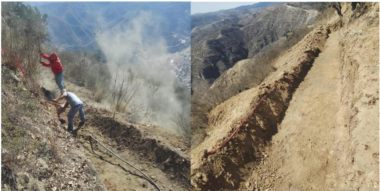
Imagen 12: Excavación para muro. Fuente: Propia.
