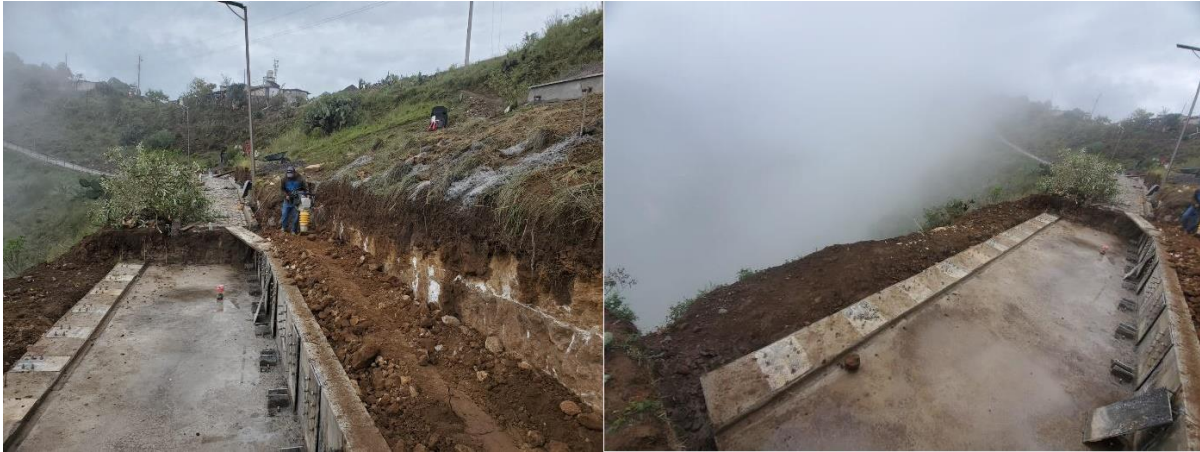
Imagen 35: Resultado del concreto fraguado de la losa de cimentación. Fuente: Propia.
