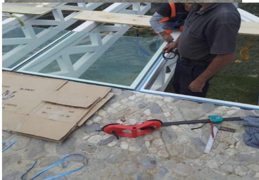
Imagen 38: Colocación de vidrio laminado. Fuente: Grupo Covico.
