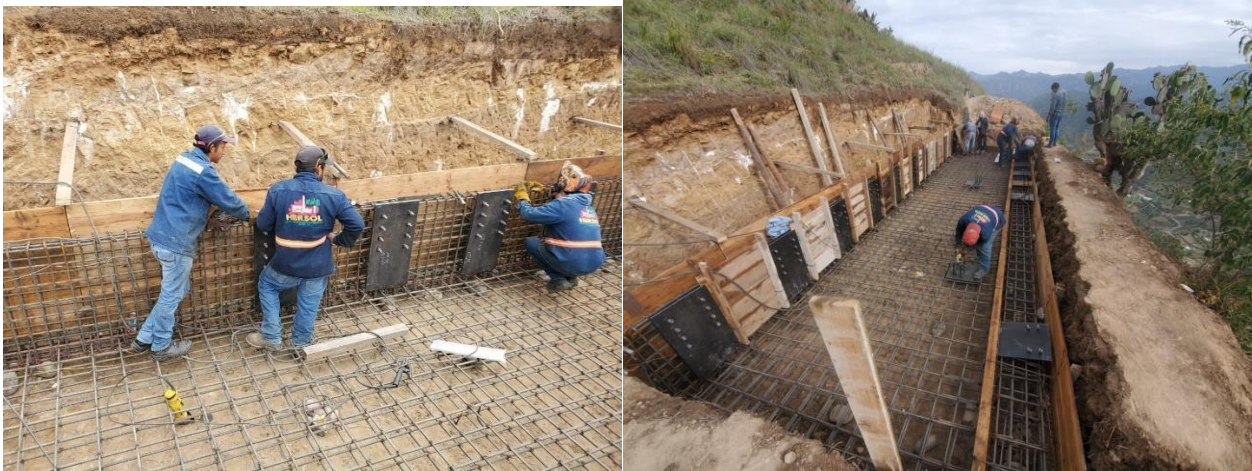
Imagen 33: Colocacion de Anclas y Placas de acero. Fuente: Propia.
