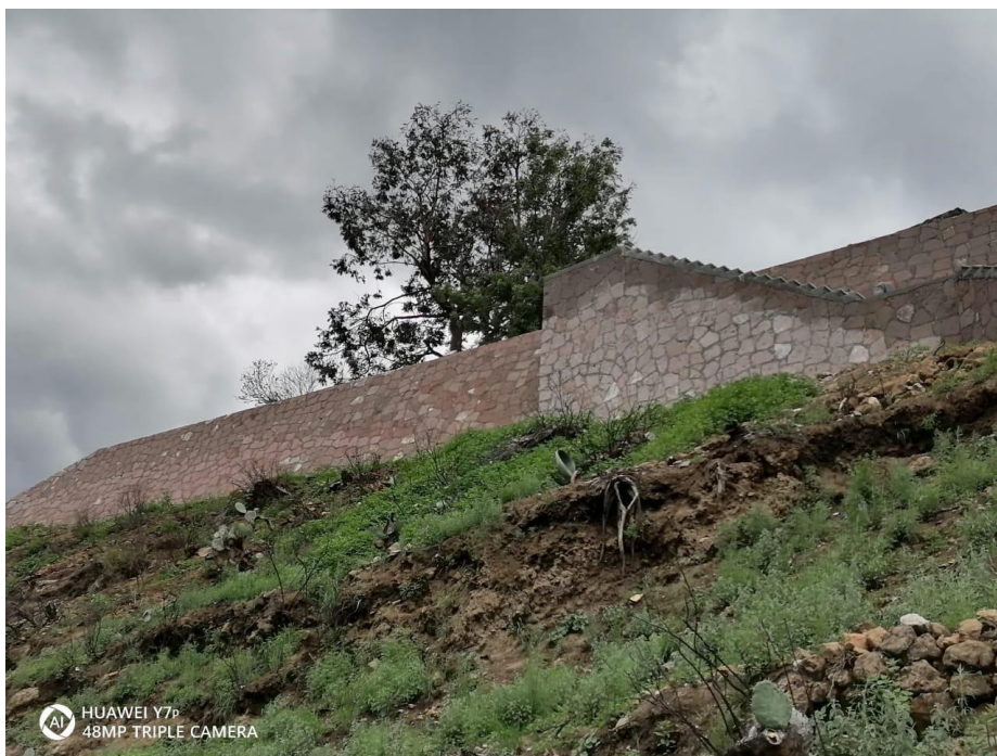
Imagen 43: Construcción de muro terminado. Fuente: Propia.
