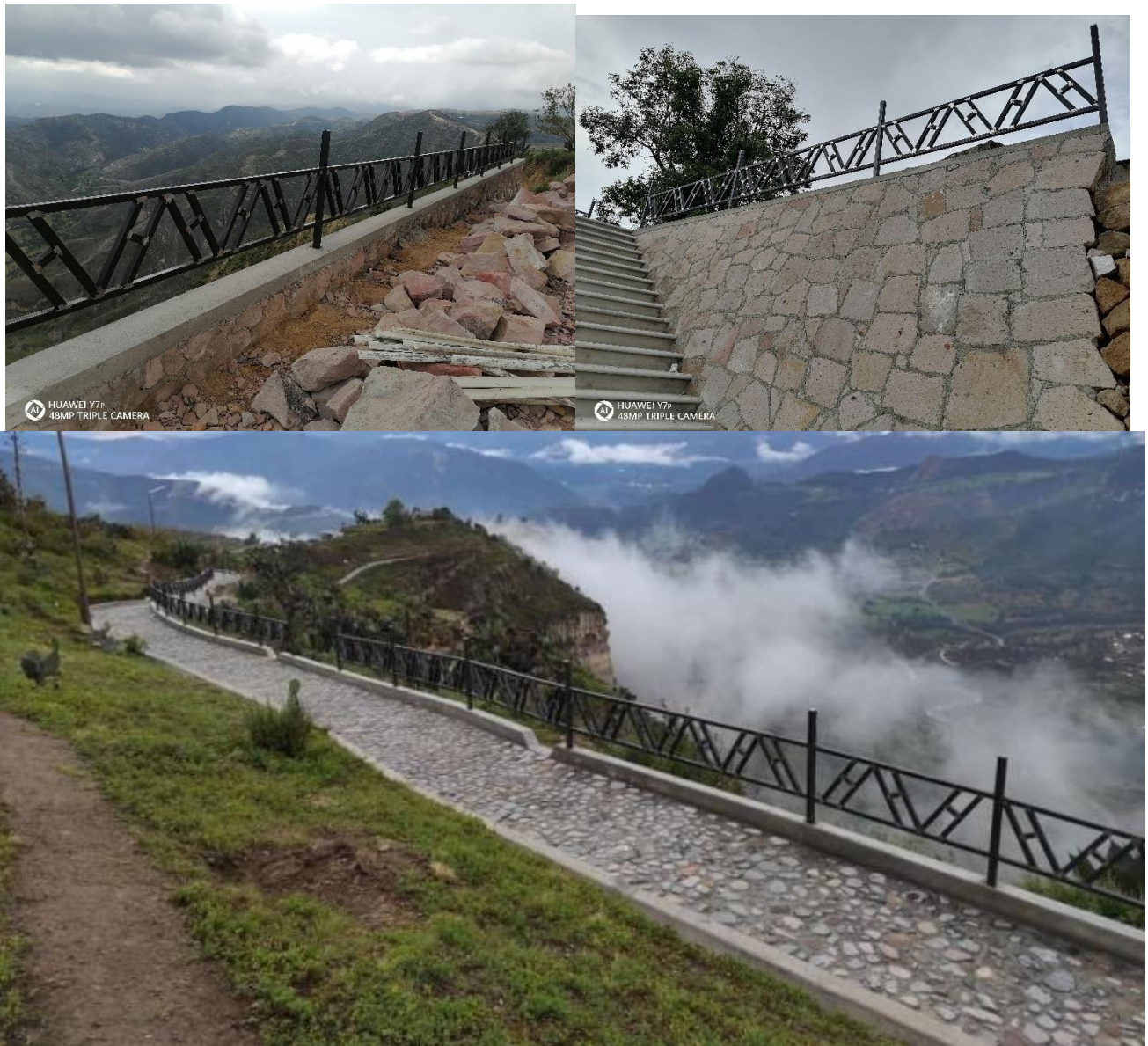
Imagen 39: Colocación de Barandal. Fuente: Propia
