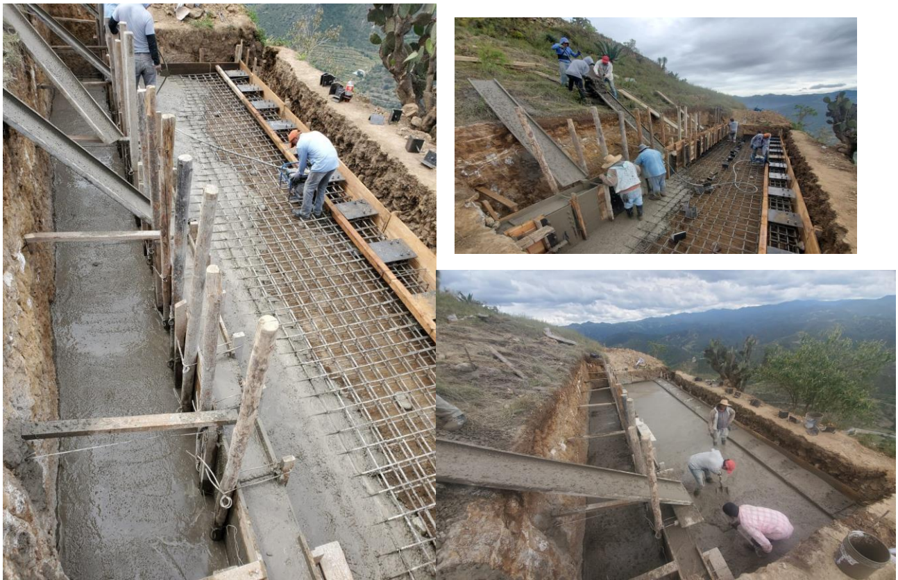
Imagen 34: Colado de losa de cimentación. Fuente: Propia.
