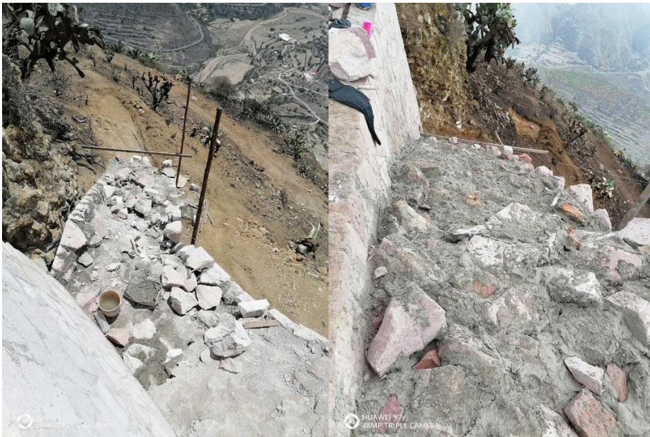
Imagen 7: Cimiento de mampostería escalera. Fuente: Propia.
