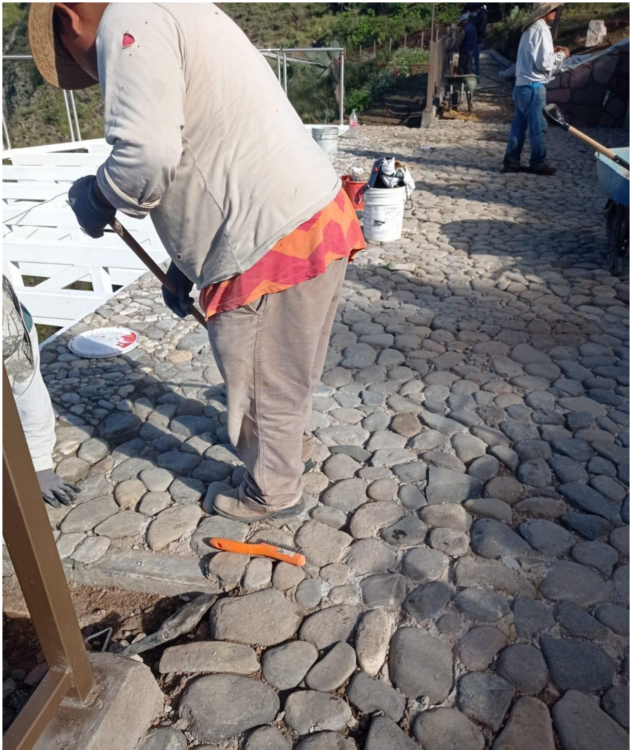
Imagen 49: Empedrado sobre estructura del mirador. Fuente: Propia.
