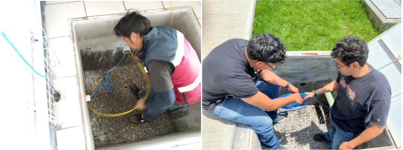
Figura 10 Preparación del área de trabajo para la implementación de enlaces de fibra óptica.
