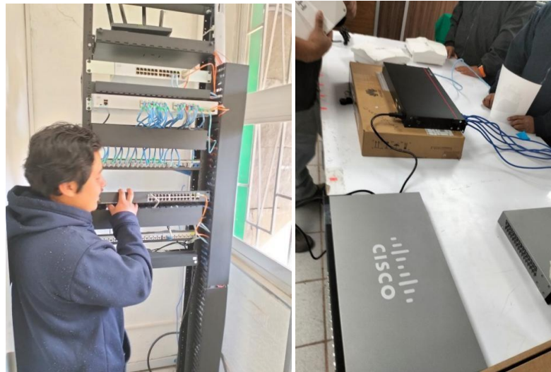
Figura 22 Sustitución de equipos de red en mal estado
