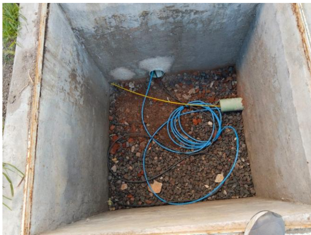
Figura 17 Montaje exterior del cable UTP.
