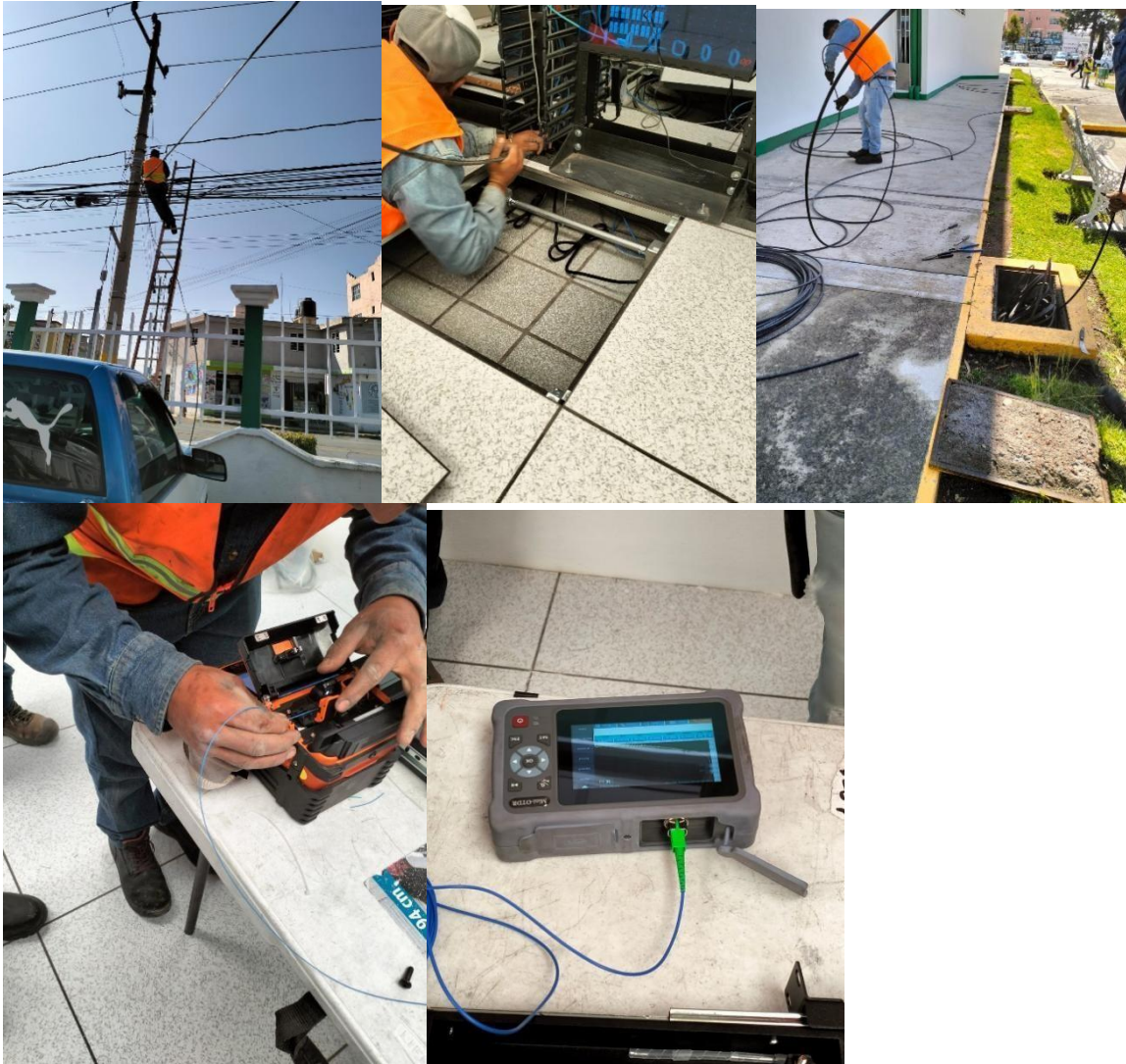
Figura 19 Supervisión del tendido y fusión de fibra óptica hacia el Edificio R (MDF)
