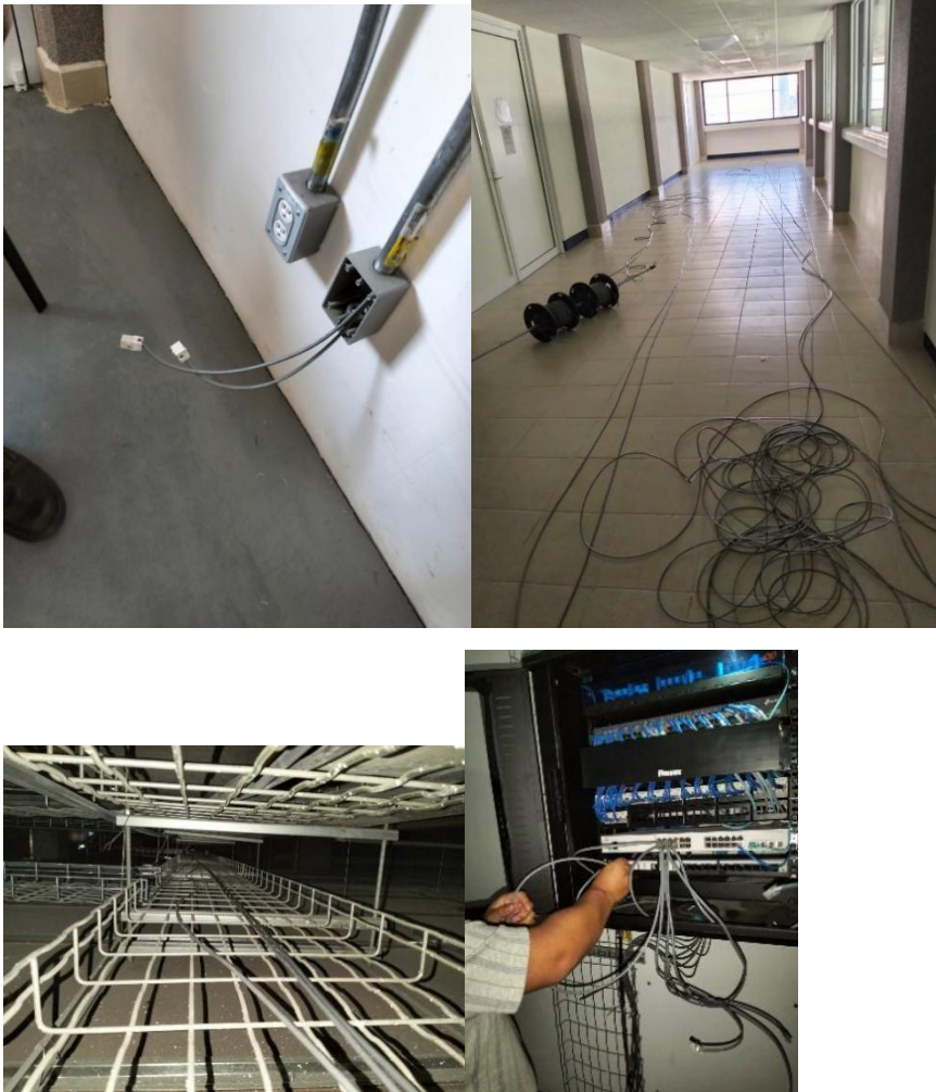
Figura 20 Instalación del cableado estructurado en el Edificio X
