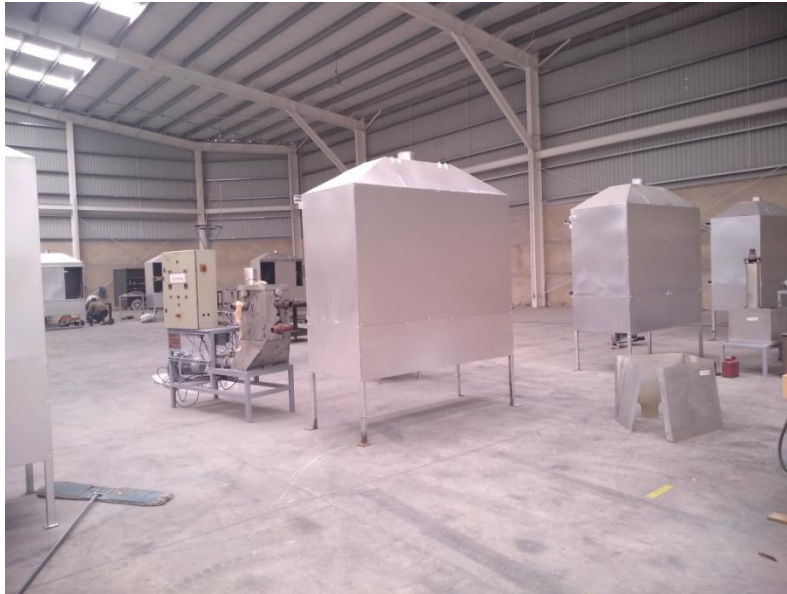
Imagen 3.1 Base de hornos eléctricos
