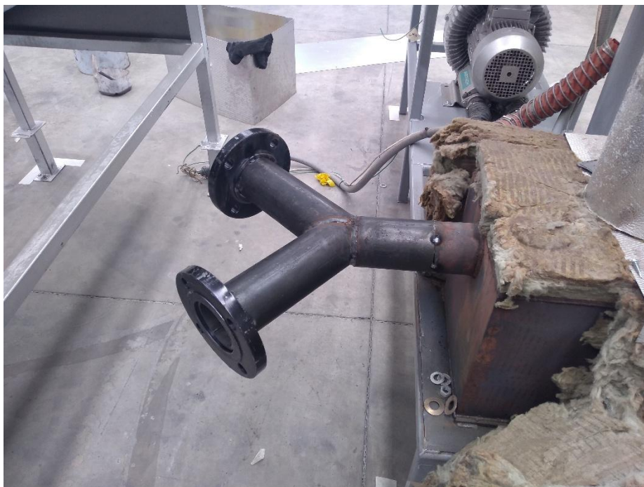
Imagen 3.84 Tuberías montadas para sus conexiones
