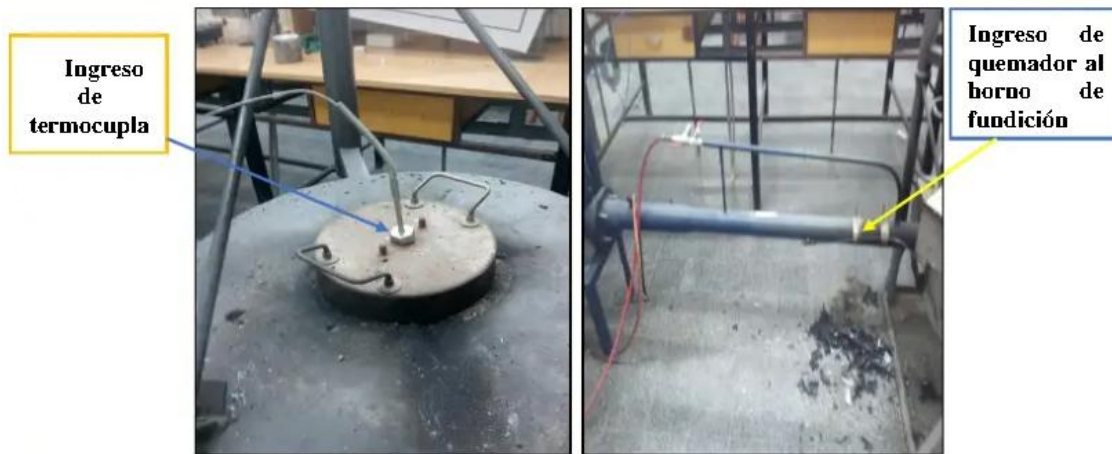
Imagen 2.50 Ingresos de quemadores de hornos eléctricos (PACHECO, 2021)
