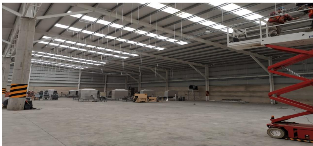
Imagen 3.32 Finalización de la canalización para la alimentación de los hornos
