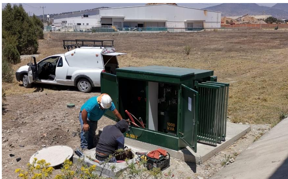
Imagen 3.71 Montaje de transformador a base y conexión.
