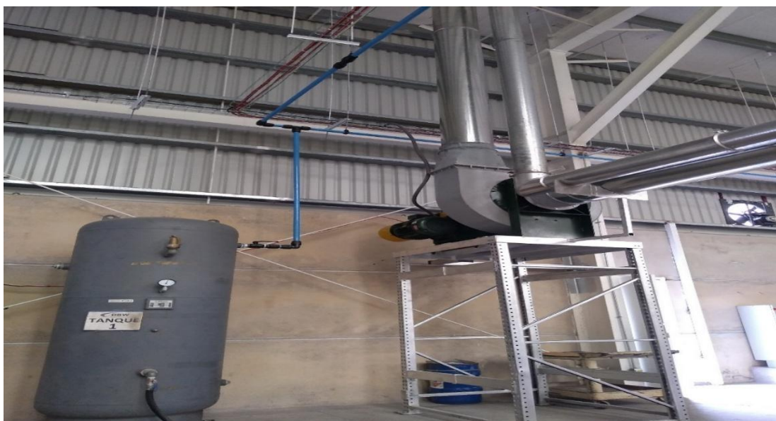
Imagen 4.9 Conexiones finales de acondicionamiento de hornos eléctricos
