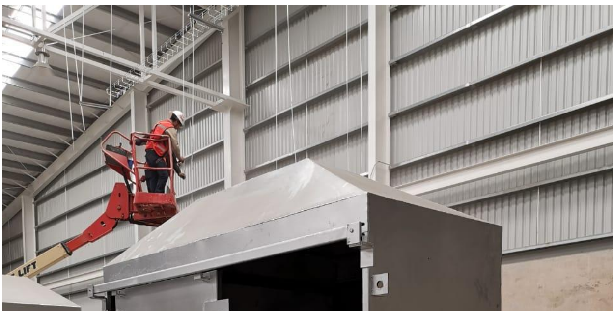
Imagen 3.34 Ejecución del detalle número 3, instalación de canaletas
