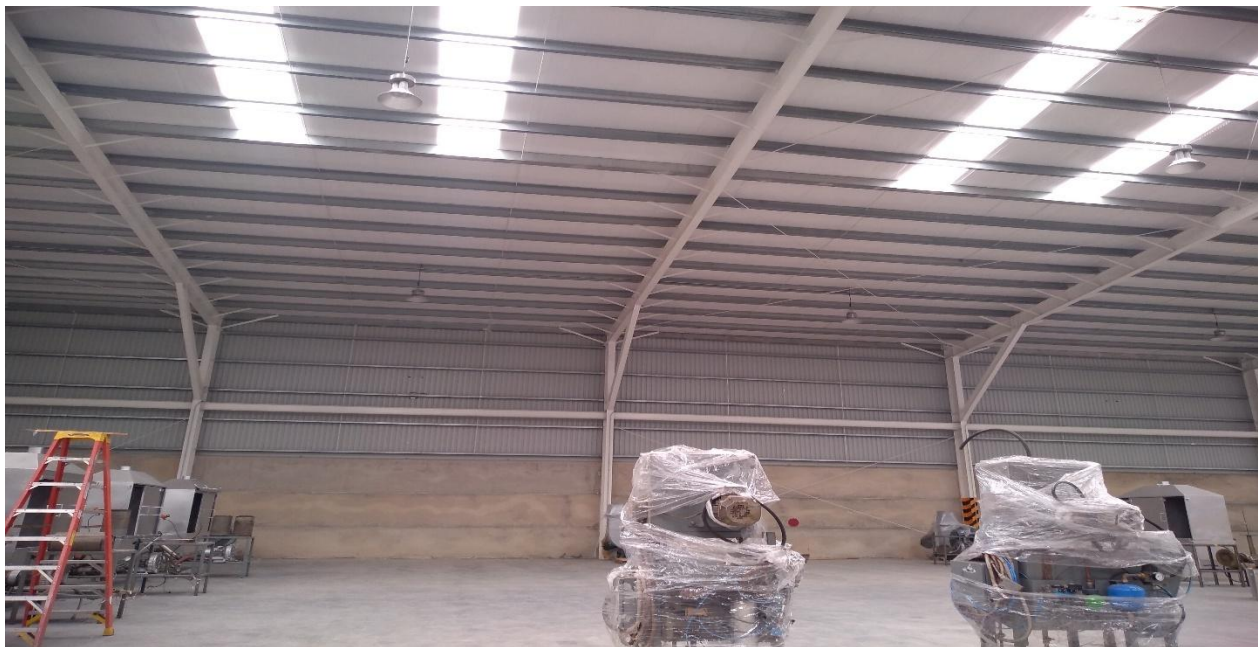
Imagen 4.1 Maquinaria y equipos.
