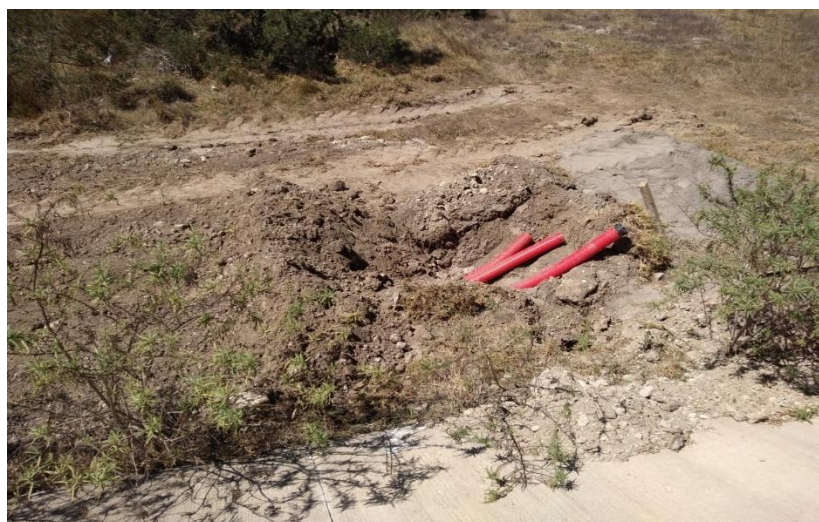
Imagen 3.53 Excavación para tuberías subterráneas de transformador y tablero QD Logic
