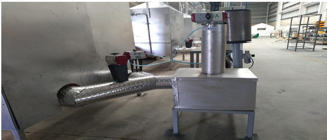
Imagen 4.8 Conexión finales del montaje de hornos eléctricos
