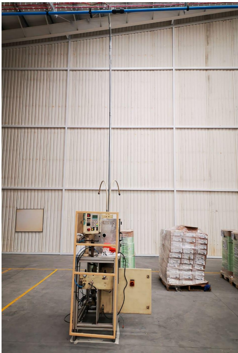
Imagen 3.27 Montaje de tubo Conduit y los ramales para conexiones de máquinas adicionales
