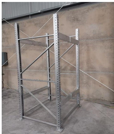
Imagen 3.90 base finalizada para extractor
