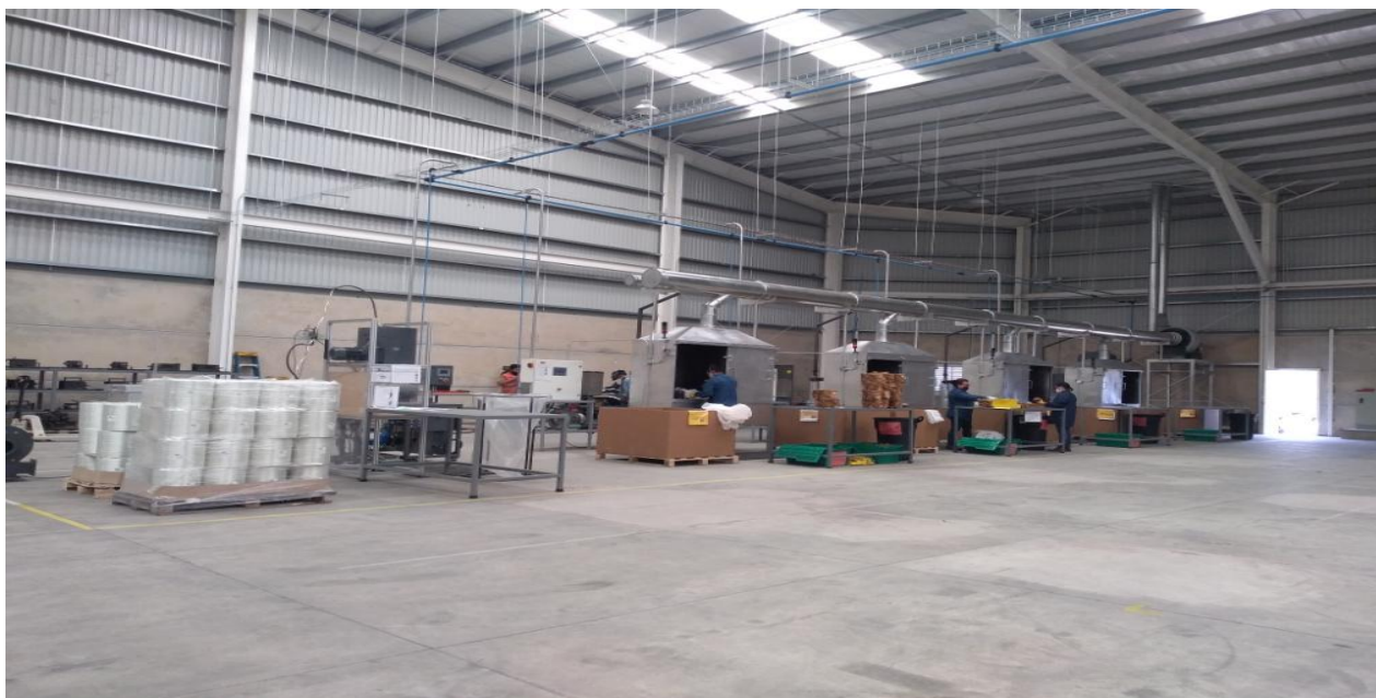
Imagen 4.3 Canalización finalizada con conexiones de hornos eléctricos y operando
