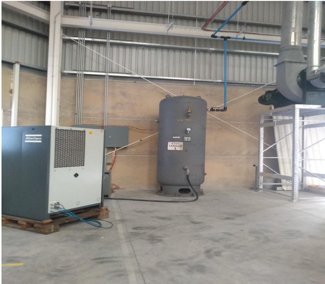
Imagen 3.87 Conexión de extracción de gases y ventilación
