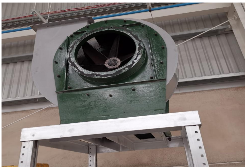
Imagen 3.88 Montaje final de extractores.
