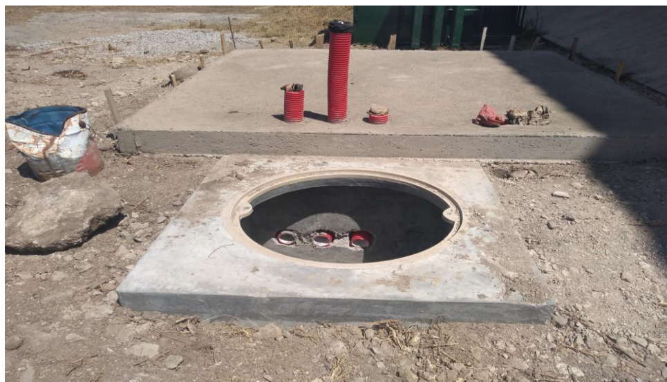
Imagen 3.70 Base y registro para montaje de transformador, colocado base al plano general
