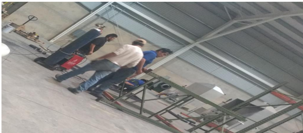
Imagen 3.89 Montaje y soldadura para base de extractor
