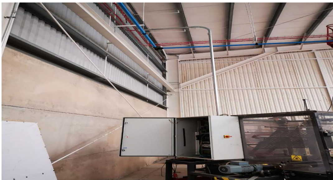
Imagen 4.4 Conexión final de maquinaria
