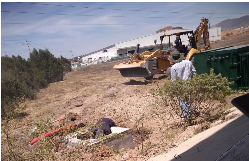
Imagen 3.69 Montaje de transformador y tuberías de conexiones
