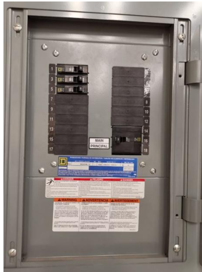
Imagen 3.5 Break de instalación de la nave inicial
