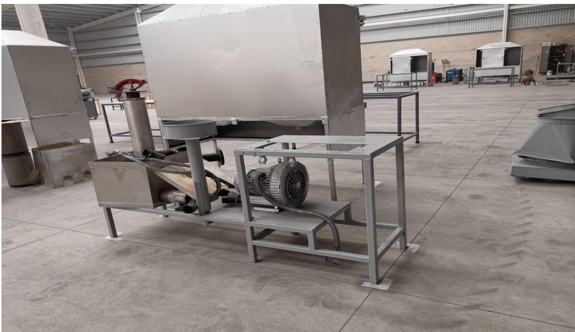
Imagen 4.7 Montaje de hornos eléctrico
