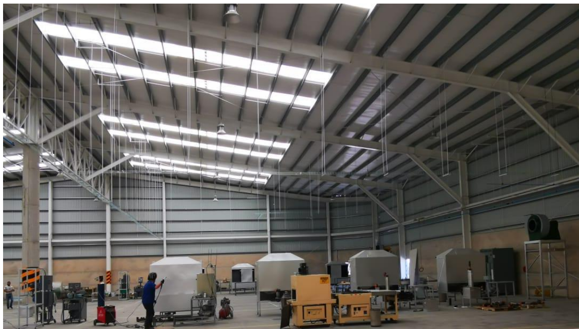
Imagen 3.36 Ejecución de detalle número 2, para alimentación de hornos eléctricos
