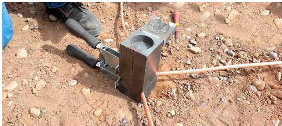
Imagen 3.75 Conexión de electrodos
