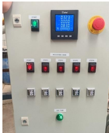
Ilustración 72. Voltaje otorgado del generador de energía al banco
