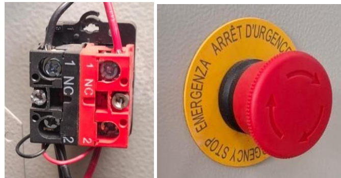
Ilustración 50. Montaje y visualización del botón de paro
