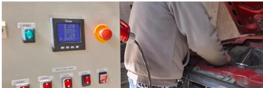
Ilustración 64. Conexión de banco resistivo con alternador
