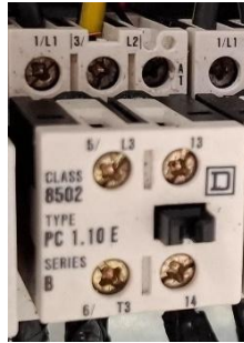
Ilustración 14. Contactor eléctrico
