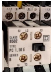
Ilustración 29. Contactor eléctrico
