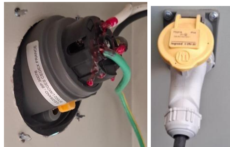
Ilustración 53. Montaje y visualización del conector de 120 v.
