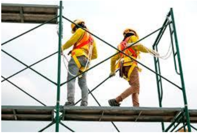
Figura: 6 Trabajo en andamios
