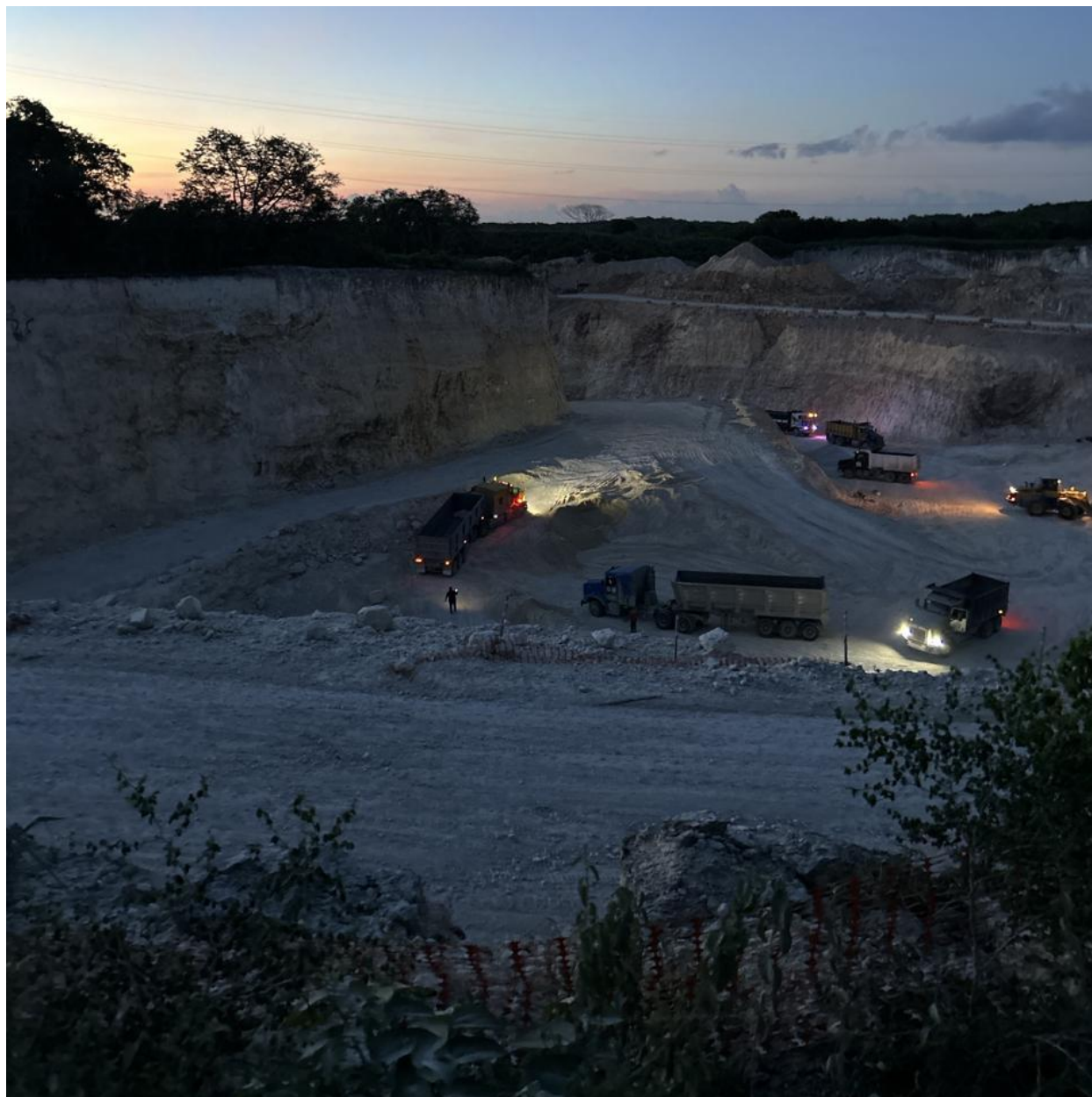
Imagen 40. Carga de materiales sub-balasto
