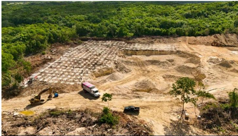
Imagen 16. Colocación de explosivos en área de voladura
