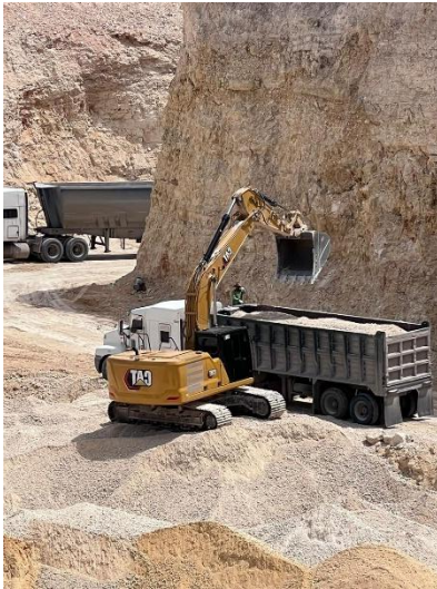
Imagen 22. Carga de material sub-balasto
