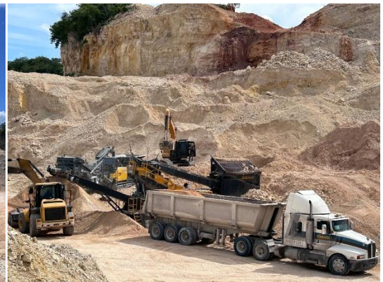
Imagen 24. Carga de material sub-brasante
