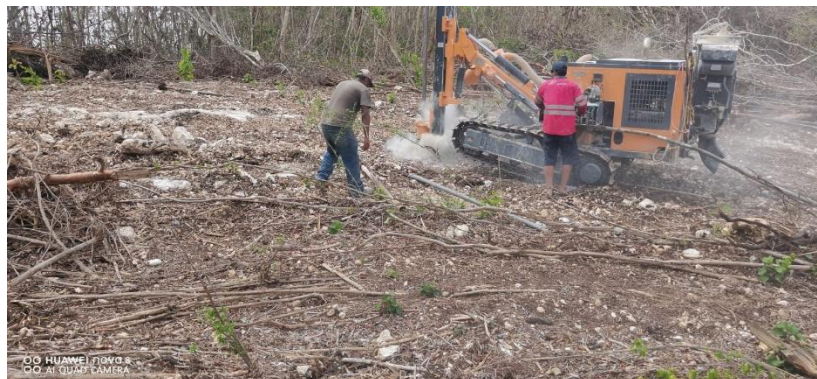
Imagen 15. Perforación de barreno largo
