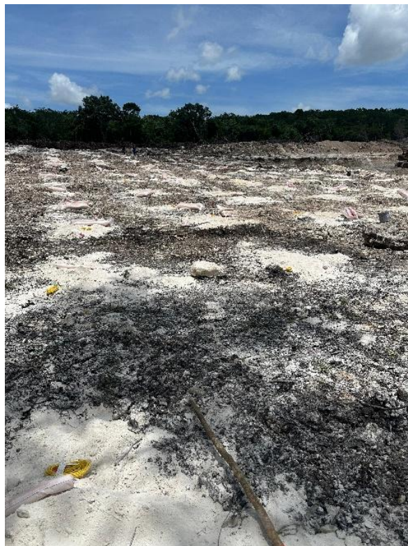
Imagen 11. Limpieza de terreno
