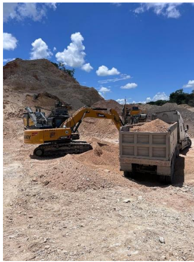
Imagen 23. Carga de material sub-balasto
