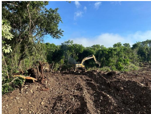
Imagen 13. Desmonte y limpieza
