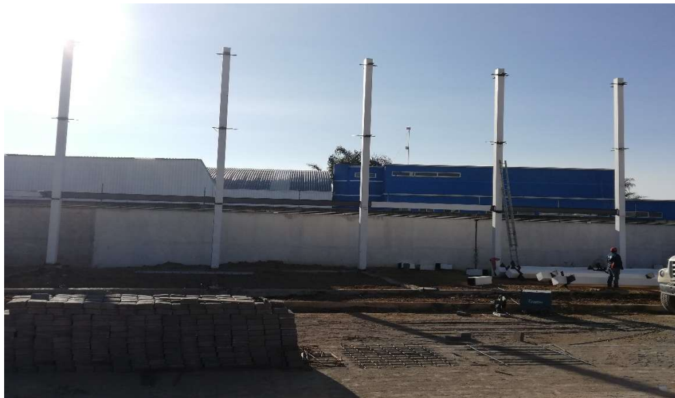
Ilustración 16 Montaje de Columnas Fuente: Propia
