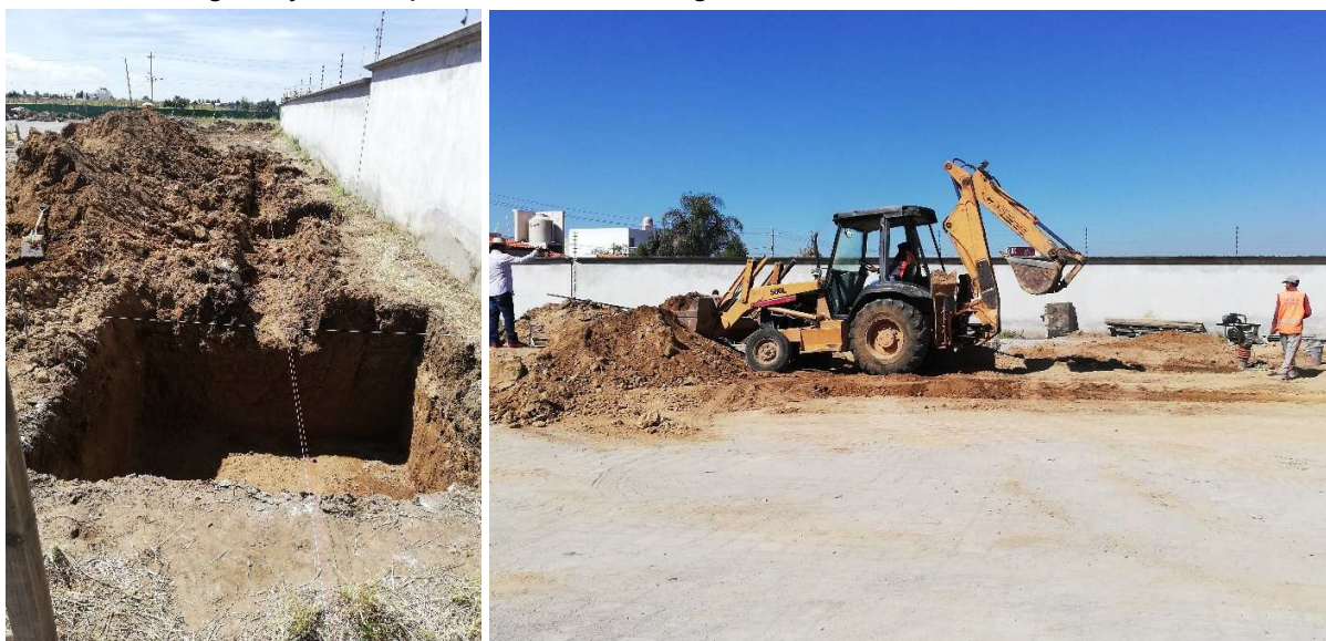
Ilustración 5 Excavación. Fuente: propia
