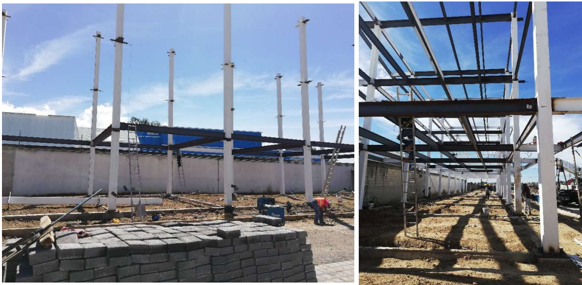
Ilustración 17 Montaje de Traves Primarias y Secundarias. Fuente Propia
