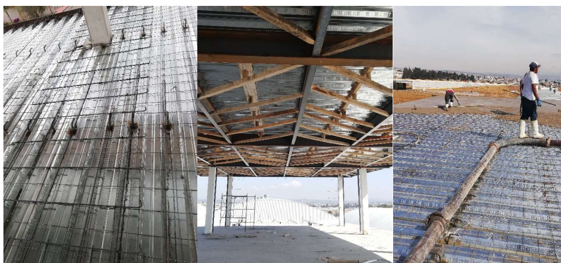
Ilustración 19 Preparación y Colado de Losacero. Fuente: Propia
