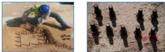
Ilustración 13 Preparación de Anclas. Fuente: Manual de Montaje de Estructuras
