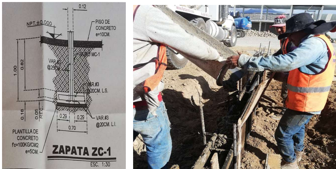
Ilustración 8 Zapata Corrida. Fuente: Propia
