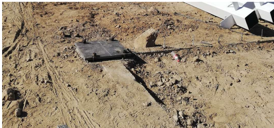
Ilustración 15 Colocación de Placas Base. Fuente: Propia
