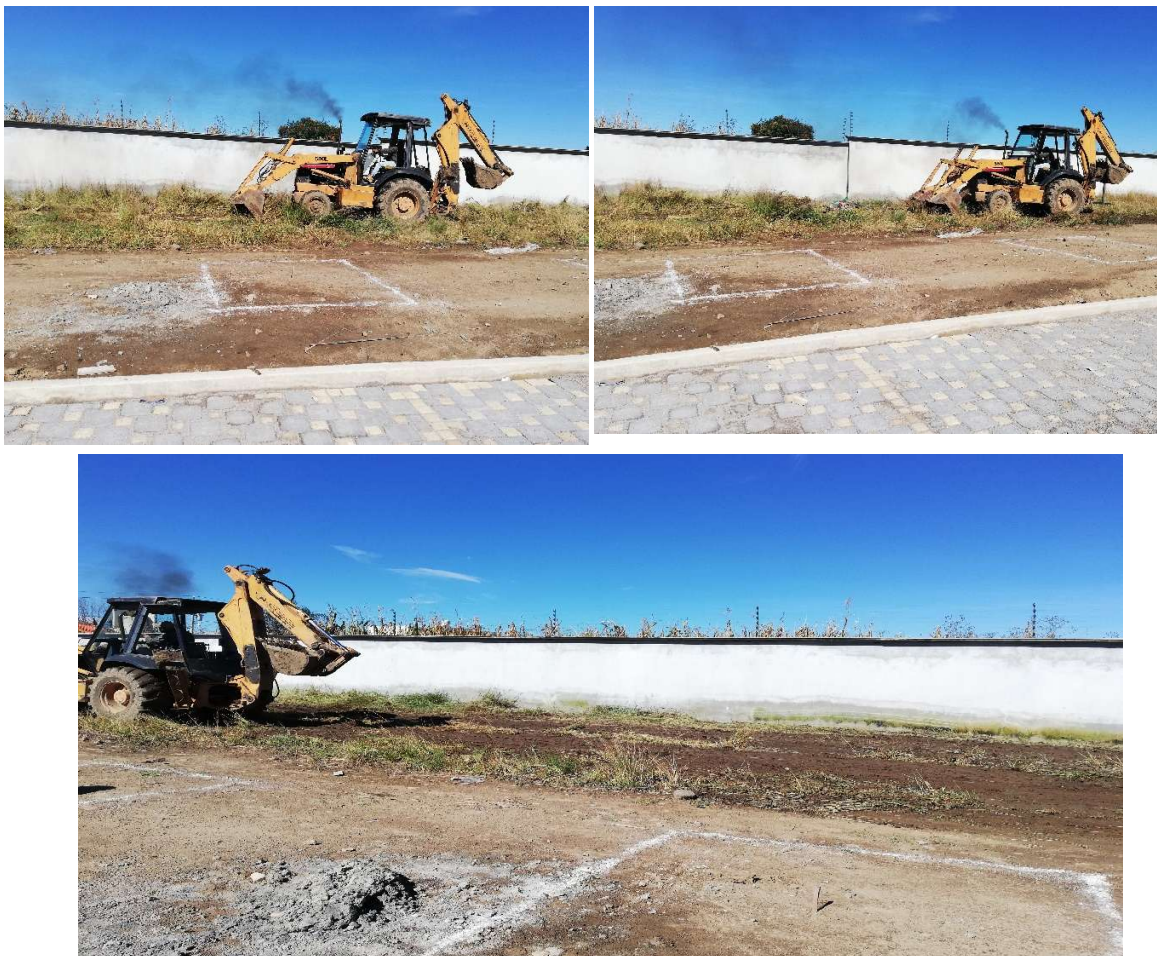
Ilustración 3 Despalme y/o Limpieza. Fuente: Propia
