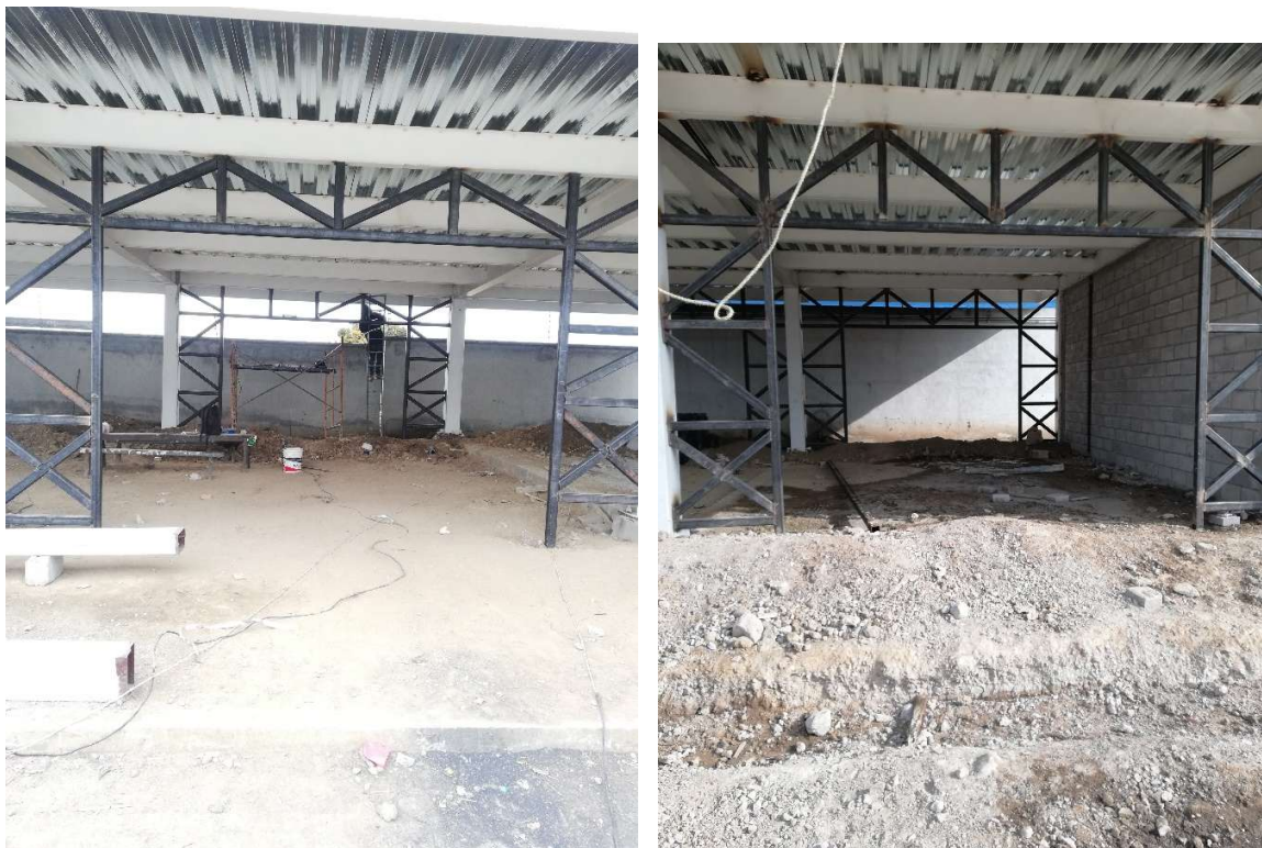
Ilustración 18 Colocación de Refuerzos. Fuente: Propia
