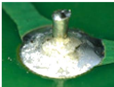
Imagen 5.17 Soldadura con agrietamiento
