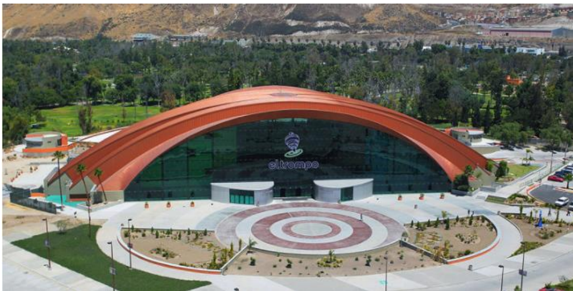
Ilustración 3. Vista Área de la Explanada Principal.
