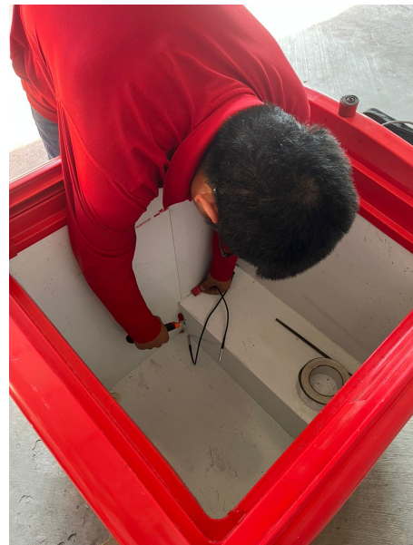
Figura 27: Sensores adentro de cámara
