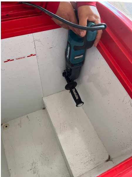
Figura 26: Perforación a la cámara
