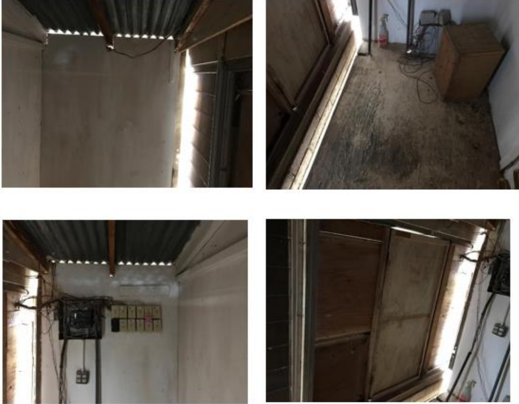
Figura 20 Vista interior del Cuarto de control de luces y sonido
