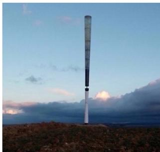
**Figura 2.8 Aerogenerador sin hélices de Vortex (Aerogeneradores, 2019)**
