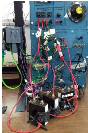
Figura 7.16. Medidor de energía conectado a un variador de tensión.
