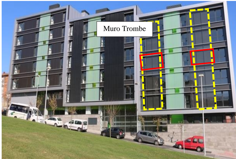
Figura 2.1. Conjunto de 32 Viviendas Sociales en Portugalete (Bizkala).
