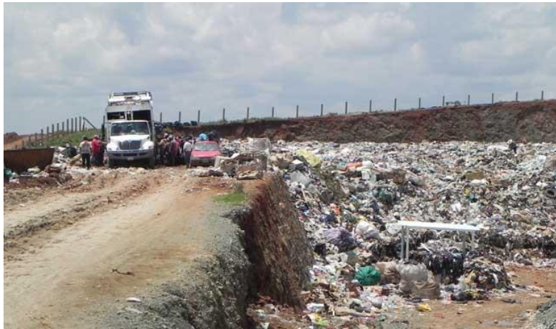
Figura 1.15 Sitio de Tierra Controlado
