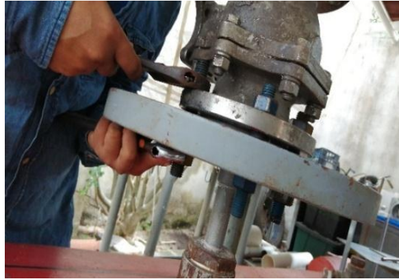
Figura 1.5. Apriete de tornillos en el montaje de válvula
