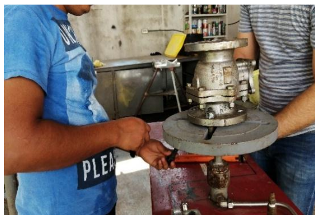
Figura 1.4 Montaje de válvula
