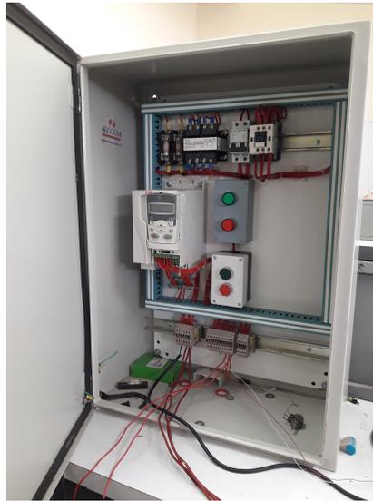
**Figura 5.6:** *Variador de velocidad montado en un gabinete.*
