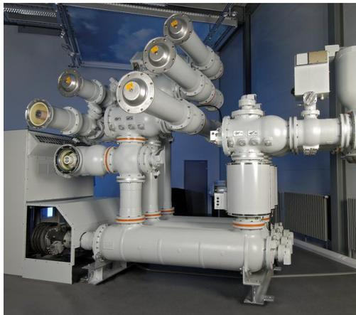
**Figura 2.1** *Aspecto típico de una subestación aislada en gas (GIS)*
