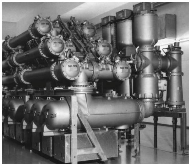
**Figura 3.1.** *Aspecto físico de una subestación aislada en gas GIS*
