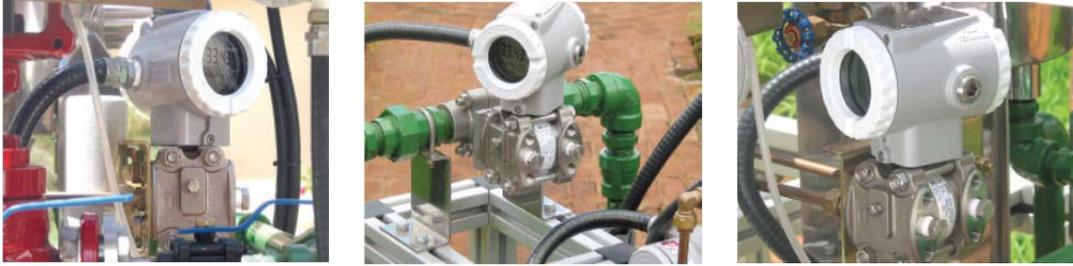
Fig. 2.25. Transmisor electrónico-digital adecuado para flujo/presión/nivel con indicador local en área de proceso.
