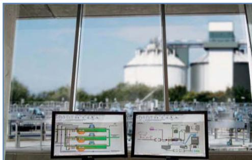
Fig. 2.36. Desde el HMI se supervisa, controla y si es necesario se corrige el proceso de producción, despliega entre otras cosas las variables, etapas y condiciones del proceso.
