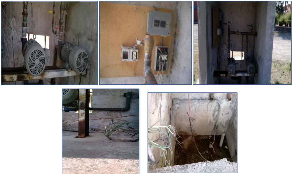
Fig. 2.4. Condiciones del sistema de bombeo antes del rediseño y automatización.
