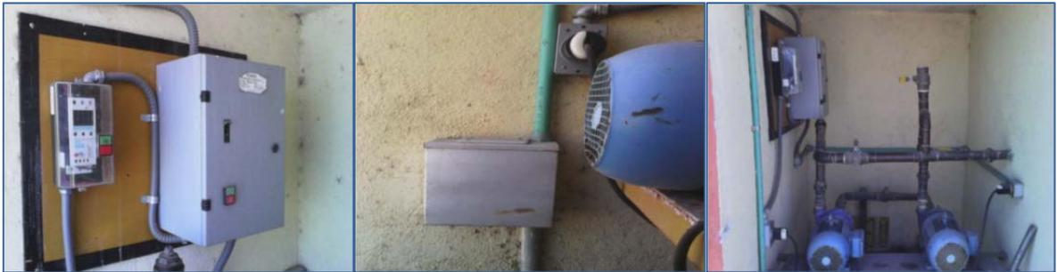
Fig. 2.5. Condiciones del sistema de bombeo después del rediseño y automatización.
