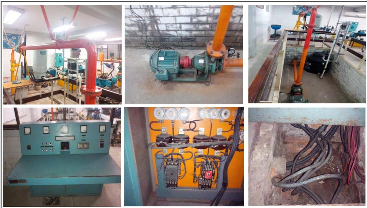
Fig. 3.1. Fotografías actuales de la instalación de la bomba centrífuga del cuarto de bombas del ITCM.
