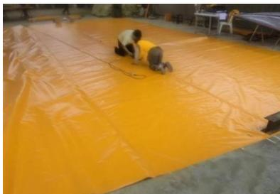
Fig 2. 20 Termosellado de lona de PVC
