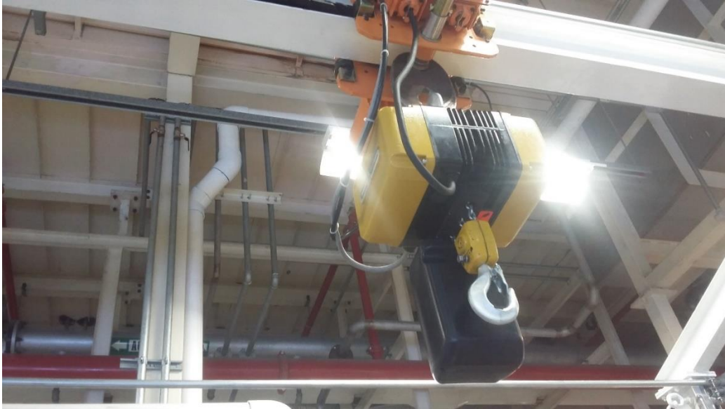
Figura 24. Polipasto montado en estructura.
