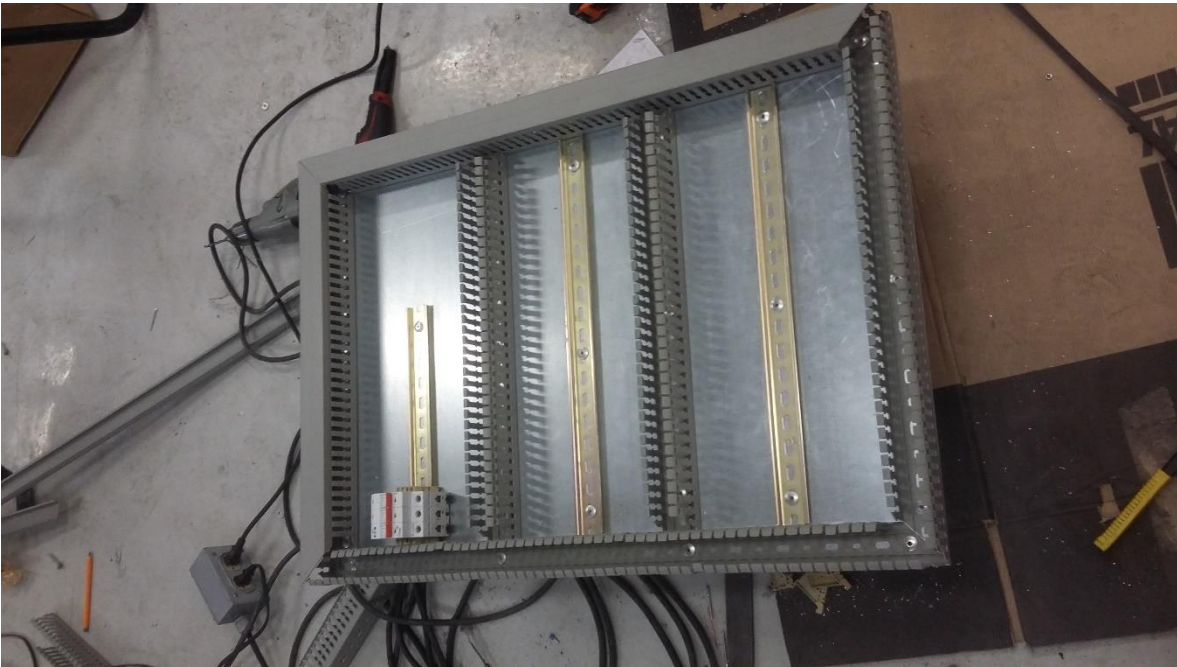
Figura 26. Construcción de la platina del tablero principal.
