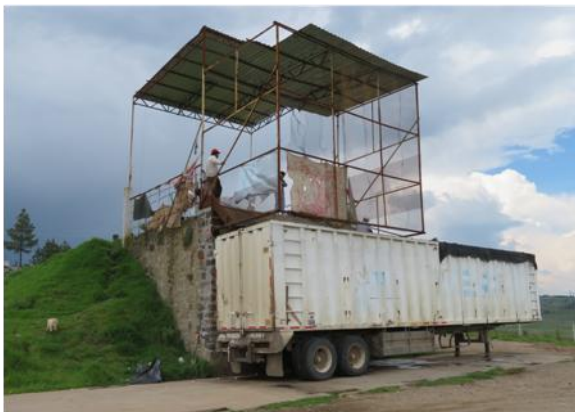
Figura 3.2 Estación de transferencia de San José del Rincón
