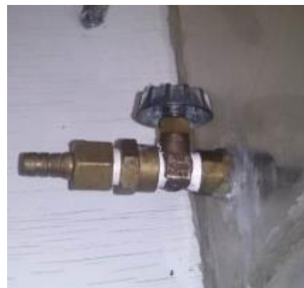
Figura B.24 Cinta teflón en llave de gas N_2
