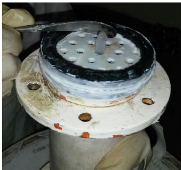
Figura B.12 Sellado de tubo de aireación del BLAB-A
