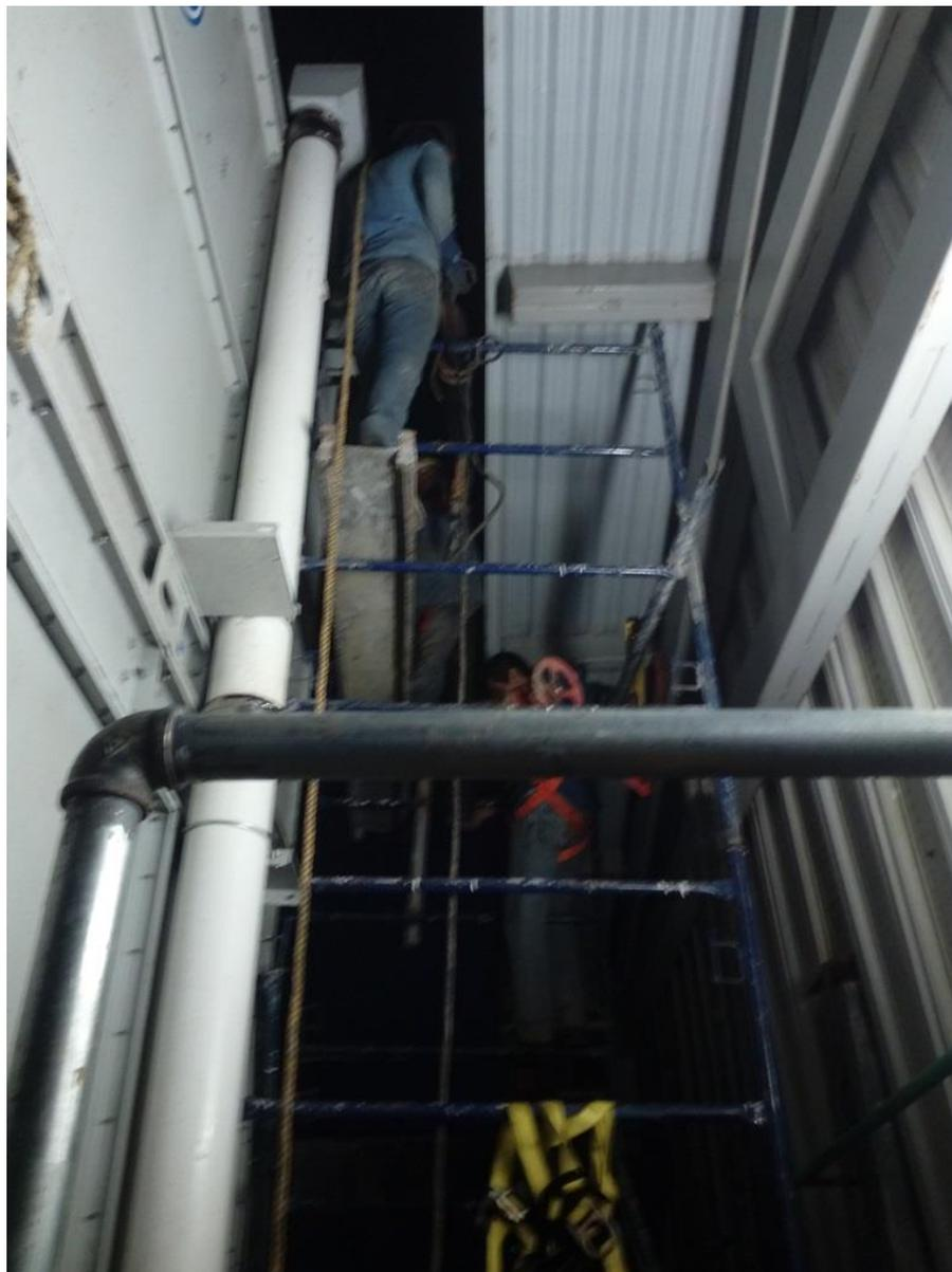
A la brevedad de tener la interconexión y haberle realizado pruebas hidrostáticas, se realiza una purga de aire para posteriormente inundar el sistema con NH3 y poder restablecer el servicio de refrigeración a planta. Al momento de tener todo listo se procede a probar equipos los cuales trabajaron sin eventualidad y sin fugas de NH3, las pruebas de operación se realizaron ya sobre la marcha pues en producción ya era muy necesario el restablecer refrigeración.
