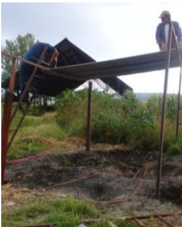
Figura 3.4 Instalación del tejado
