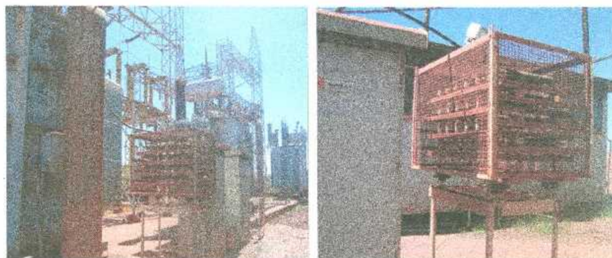
Figura 3.7. Resistencias de puesta a tierra de 20 Ohms, 400 Amp, 10 Seg.
