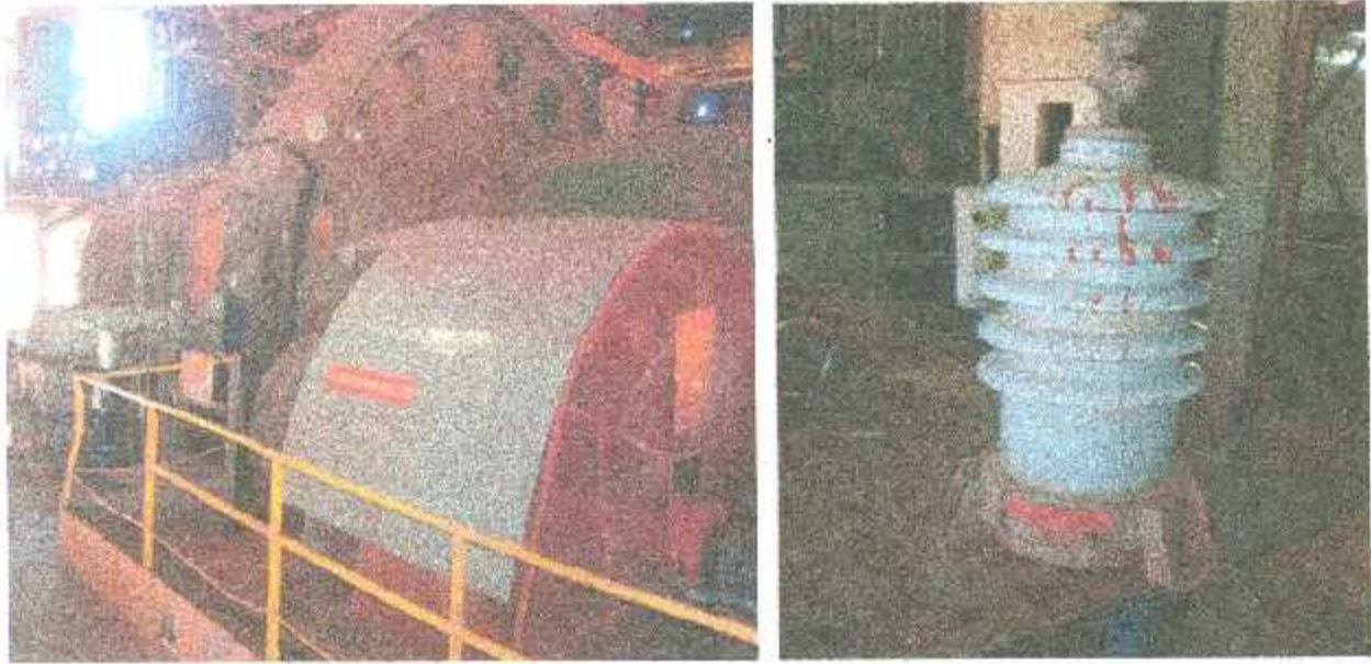
Figura 3.1. a) Motor síncrono "Molino Primario" de LPL, b) Apartarrayos de 15 kV tipo estación.
