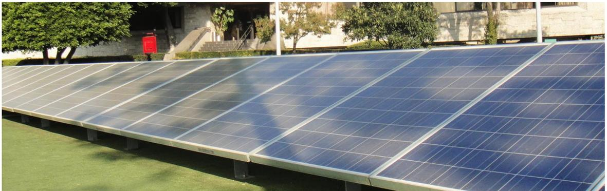
Figura 23. Sistema fotovoltaico operando en condición de sombreado parcial
