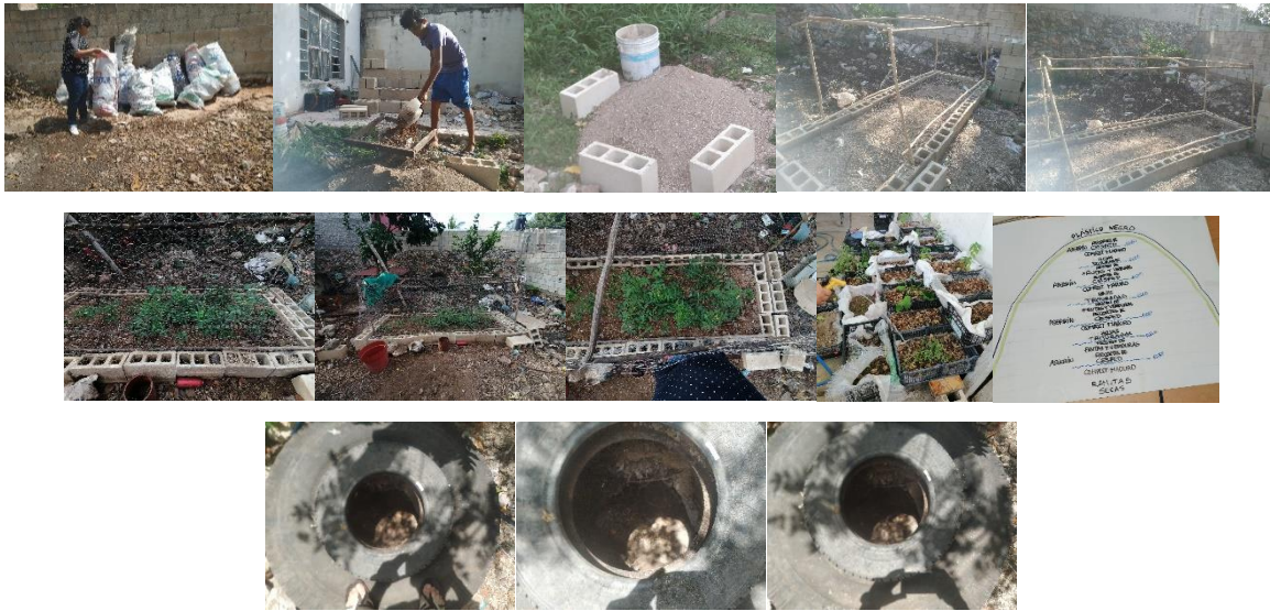
Figura 25. Instalación del huerto urbano y sistema de composteo en la vivienda S463
