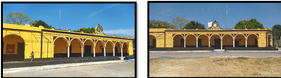
Figura 5.2 Edificio de la comisaría de Dzityá
