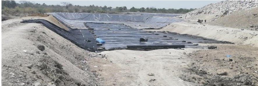
Fig 4 Relleno Sanitario El guayabo Fuente: Google Earth 2020.
