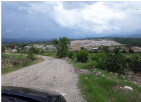
Fig 10 Acceso al relleno sanitario de Martínez de la Torre. Fuente: Propia 2020.
