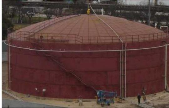
Fig.14 Tanque atmosférico techo fijo
