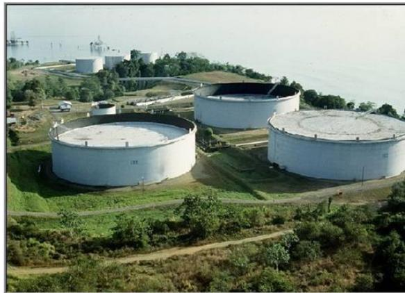
Fig.15 Tanque atmosferico de techo flotante
