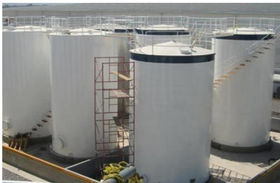
Fig.13 Tanque atmosférico
