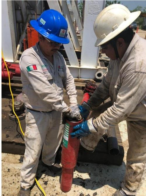
Ilustración 41 Introduciendo molino fresado de 4”
