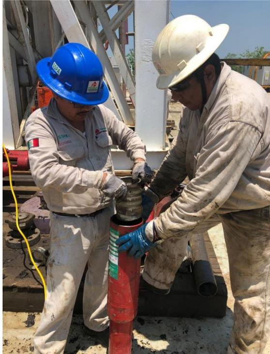
Ilustración 43 Introducción de la cuña canasta 2 7/8
