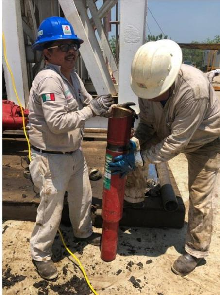
Ilustración 44 Armado del pescante Bowen Over Shot 150
