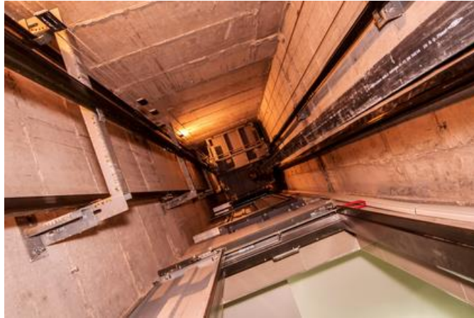
Figura 7. Hueco de un sistema elevador.
