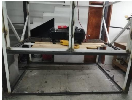
Figura 68. Construcción de la cabina acoplada a la estructura
