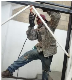
Figura 67. Soldando PTR de 1 pulgada
