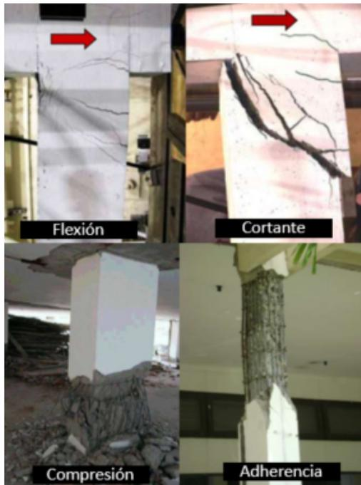
Figura 3.3 Tipos de fallas en columnas de concreto.
