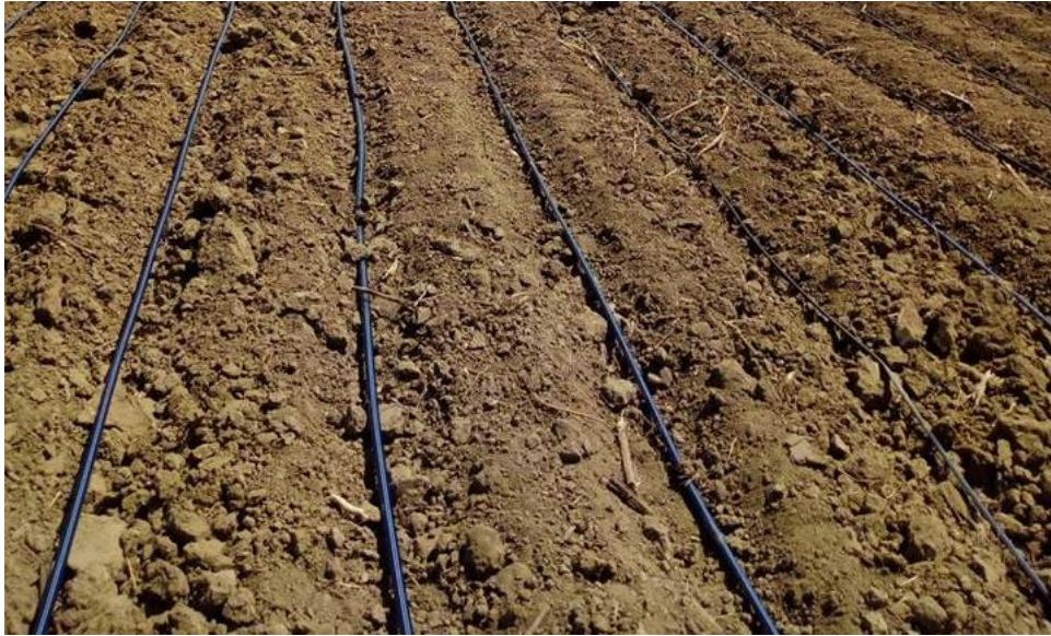
Figura 5. Colocación de cintillas
