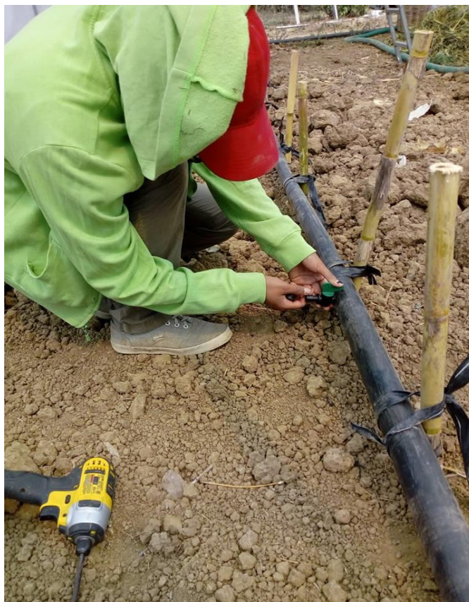
Figura 4. Instalación del sistema de riego
