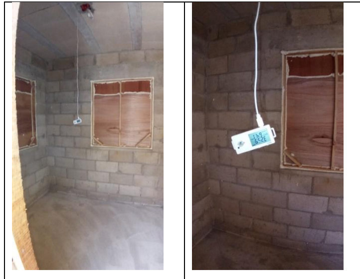
Figura 41. Instalación de hobos.
