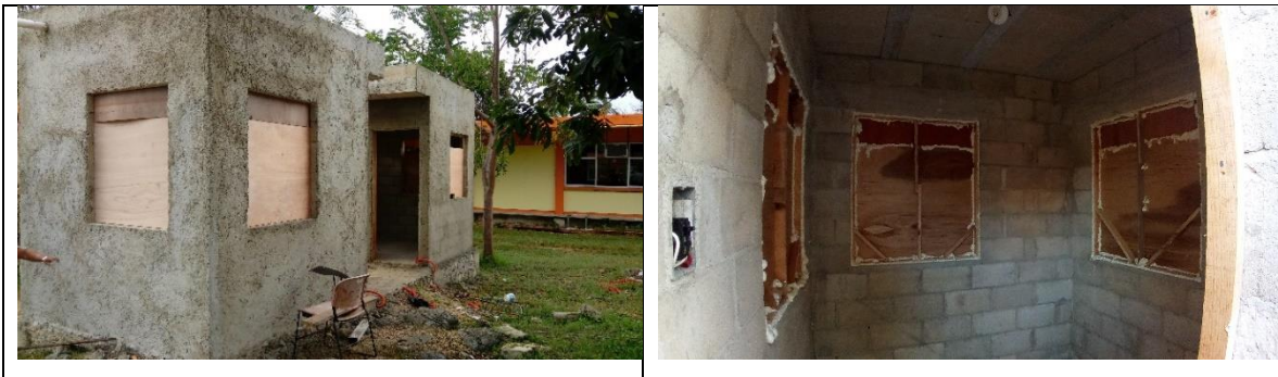
Figura 40. Sellado de prototipos con espuma expandible de poliuretano.
