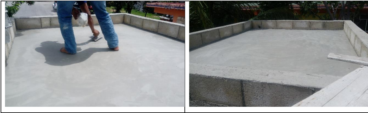
Figura 36. Colocación de Calcreto de 5 cm de espesor.
