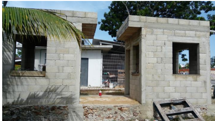
Figura 16. Elaboración de prototipos de 2.5 x 2.5 x 2.6 metros.
