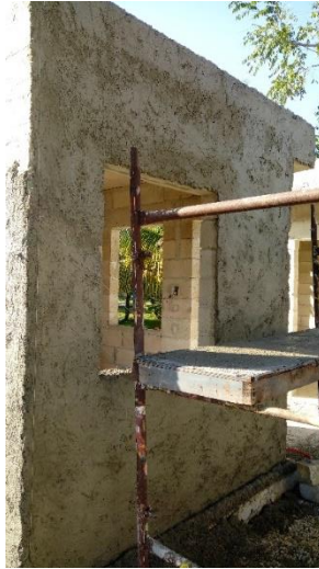
Figura 39. Aplicación de envolvente térmica con acabado rustico.
