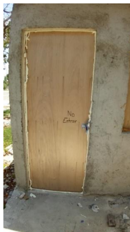
Figura 42. Sellado de puertas y ventanas con espuma de poliuretano expandible.
