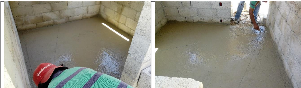
Figura 37. Firme de concreto con acabado rustico.
