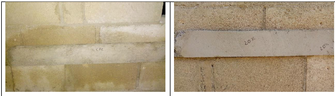
Figura 20. Aplicación de mortero sobre muro de block.
