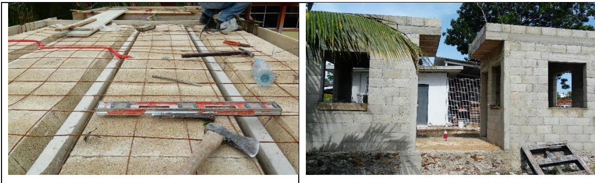
Figura 35. Siembra y losa de vigueta y bovedilla.
