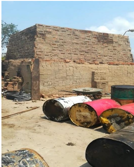
FIG. 2.2. 10 TABIQUERA MARIO GOMEZ (AUTOR PROPIO)
