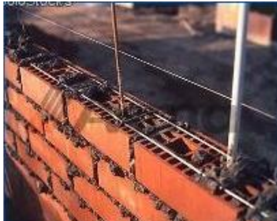
FIG. 1.1.1. 9 MAMPOSTERIA PARCIALMENTE REFORZADA OBTENIDA DE: MATHEUS HECTOR, n.d.)
