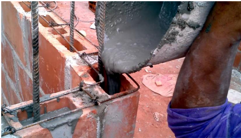
FIG. 1.1.1. 5 MAMPOSTERIA ESTRUCTURAL (OBTENIDO DE: UNKNOWN, N.D.)
