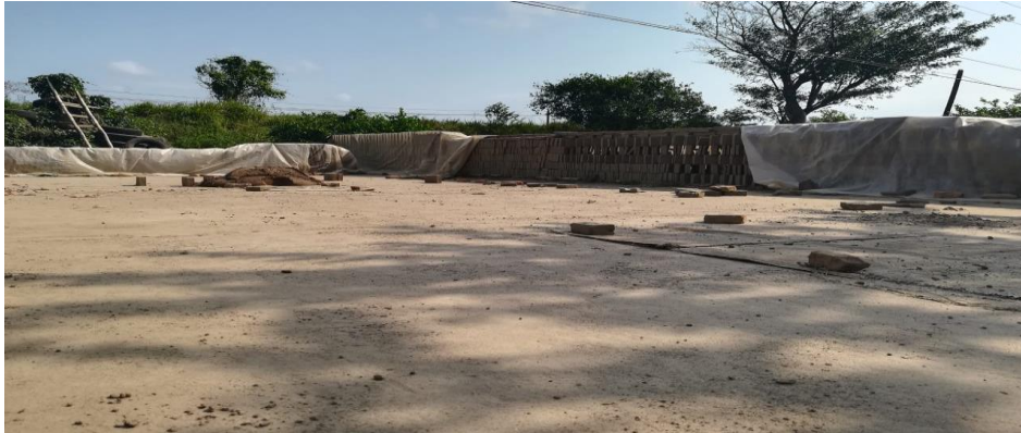
FIG. 2.2.4. 1 PATIO DE SECADO (AUTOR: PROPIO)
