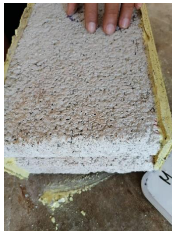
FIG. 3.5. 7 FRACTURAS EN EL BLOCK (AUTOR PROPIO)
