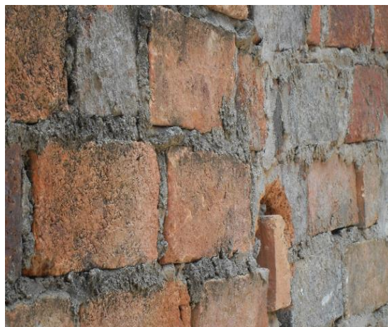
FIG. 1.1.1. 3 MAMPOSTERIA CONFINADA (OBTENIDA DE: MANUEL CHIQUILLO Y EDYES GONZALES, N.D.)
