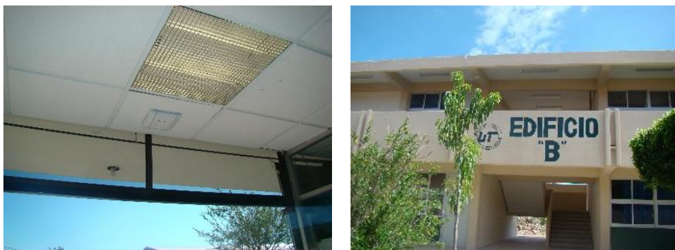
Figura 3.4.4. Instalación de puntos de acceso en el edificio principal. Y edificio B. (Fuente Propia)
