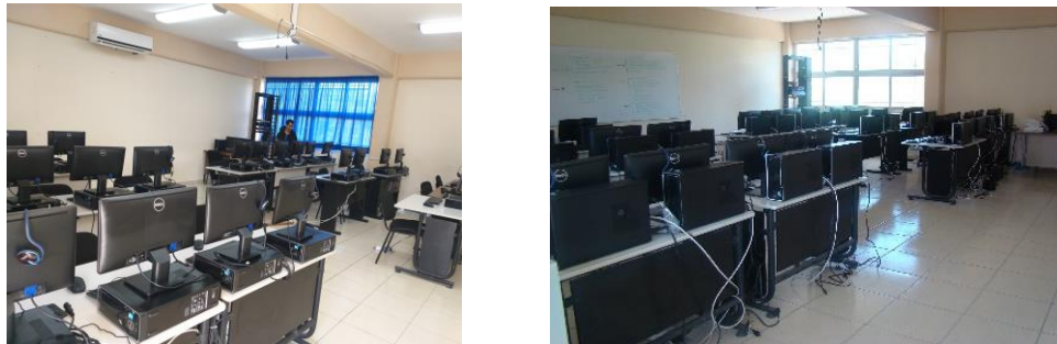
Figura 3.4.3. Instalación de equipo de cómputo del laboratorio de idiomas. (Fuente Propia)
