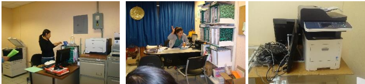
Figura 3.4.7 Instalación de impresoras en las diferentes áreas de la unidad académica. Uarm. (Fuente Propia)
