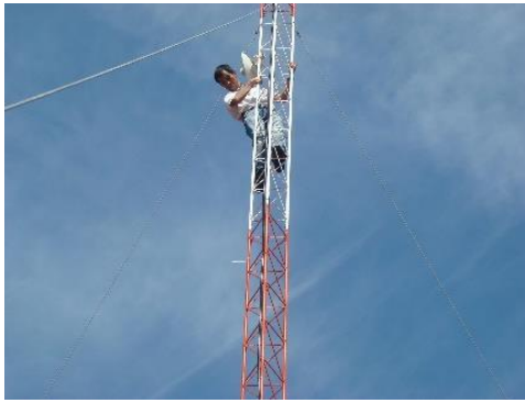
Figura 3.4.5. Colocación de punto de acceso en antena receptora. (Fuente Propia)
