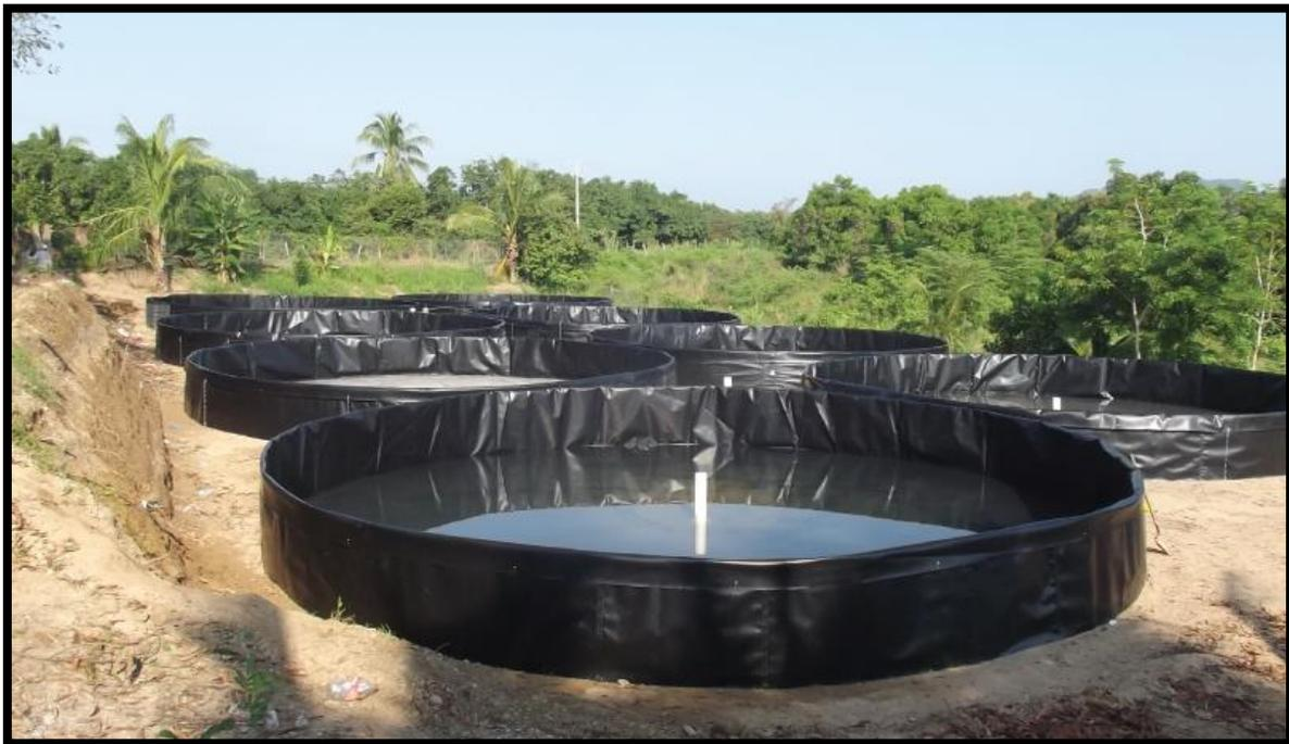
Figura 8. Estanques de geomembrana.
