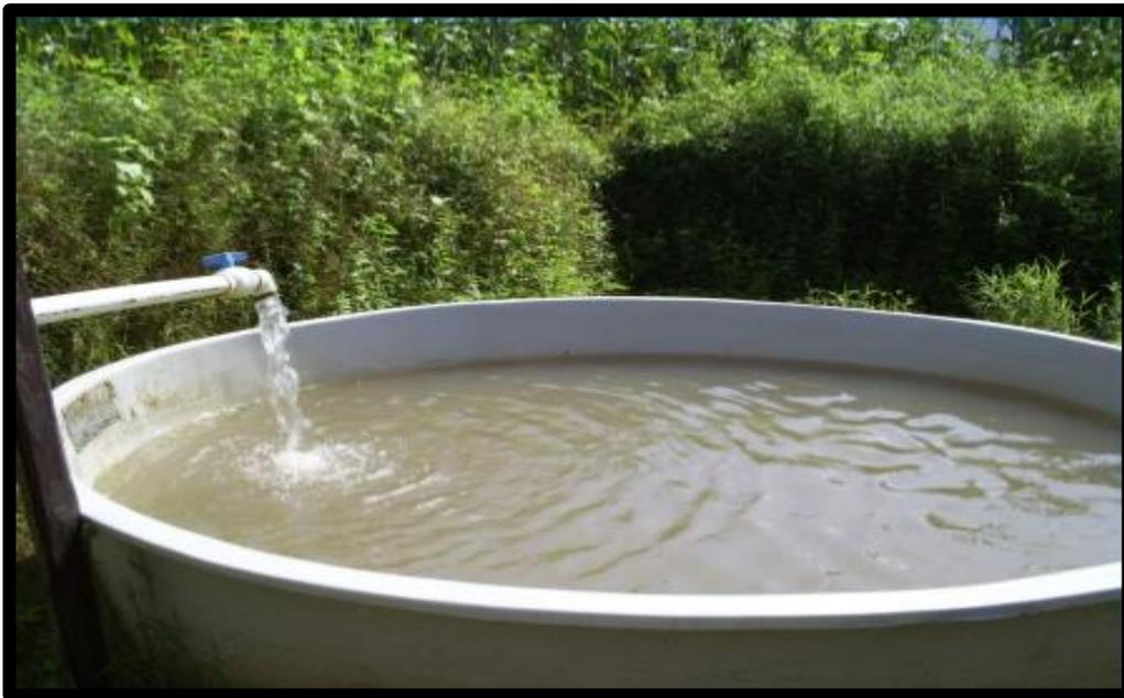
Figura 6 Ejemplo de Estanque elaborado a base de cemento.
