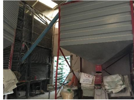
Silo y Tolva
