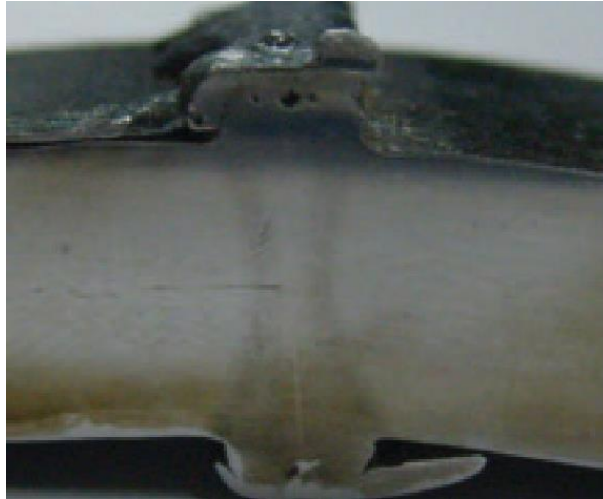
Figura 8. Metalografía de corrosión en una sección transversal [19].
