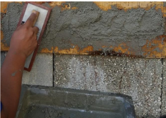
Fig. 3.23.- Aplicación de recubrimiento.
