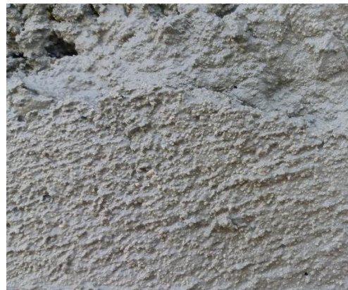
Fig. 3.24.- Acabado final aplanado.
