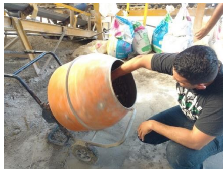
Fig. 3.29. Mezcla de los materiales con los elementos faltantes del cemento y el agua.
