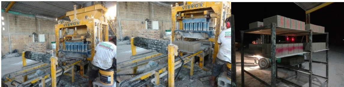
Fig. 3.30. Vibro compactado para la elaboración de los bloques.
