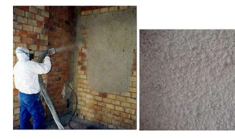
Ilustración 2.6.- Lana de roca proyectada (mortero tecwool)
