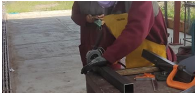
Figura 3.16. Corte de piezas a las medidas y tipo de corte requerido
