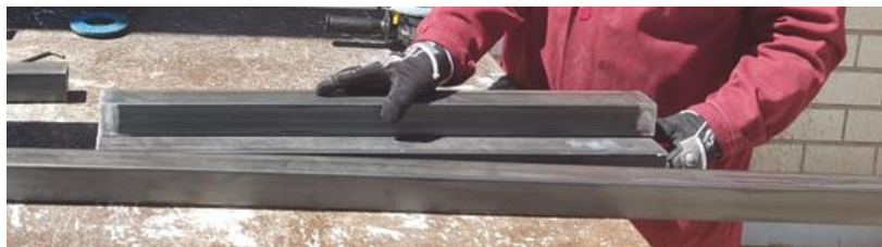
Figura3.4. Obtención de todas las piezas para la estructura inferior.
