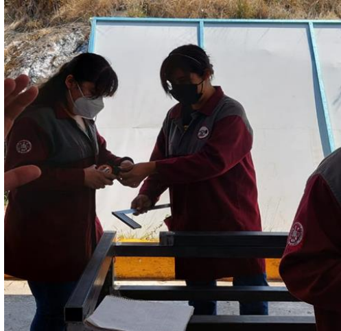
Figura 3.10. Revisión de medidas de la estructura principal terminada.
