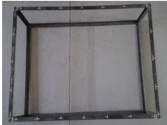
Figura 3.22. Barrenos realizados en la parte inferior de la estructura.
