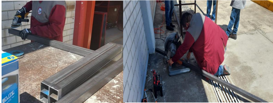
Figura 3.3. Corte de piezas a las medidas y ángulos requeridos.
