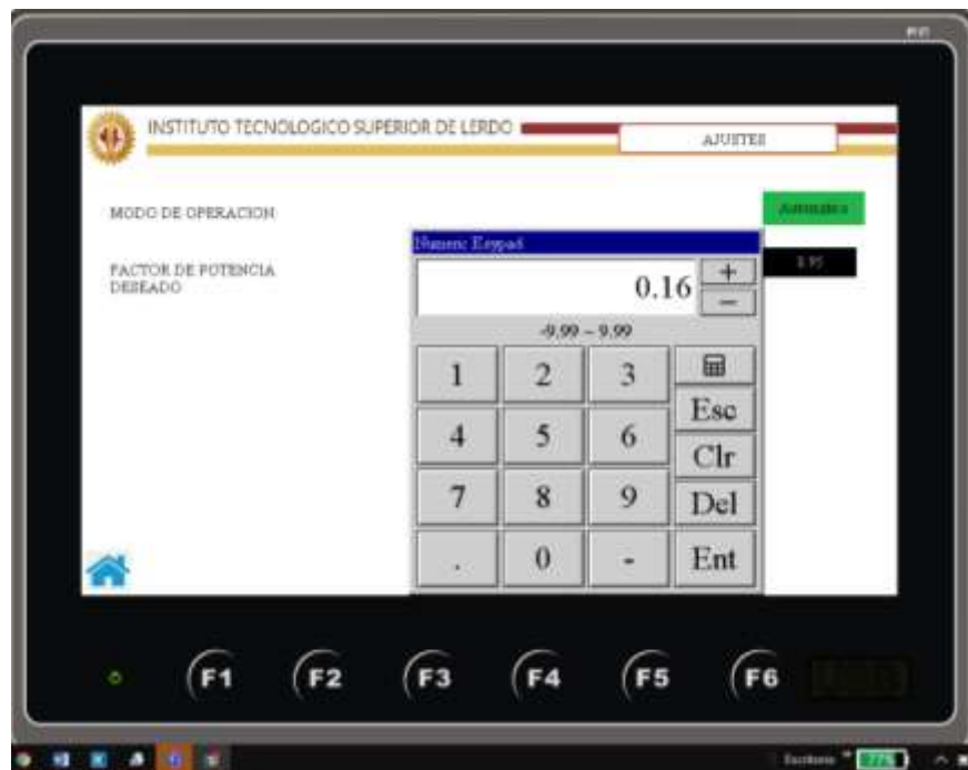
Figura: 130; Para probar desactivación de capacitores se introduce FP menos al actual en Pantalla HMI “04 de AJUSTES” en simulación.
