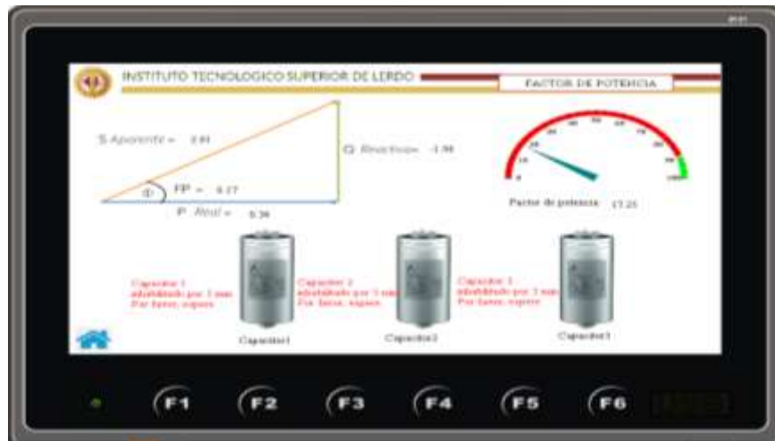
Figura: 131; Pantalla HMI “01FACTOR DE POTENCIA” de simulación, los tres capacitores desenergizados.
