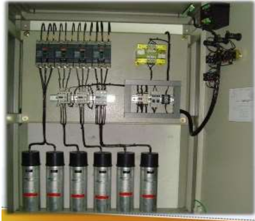
Figura: 5; Montaje de un tablero de un banco de capacitores automático
