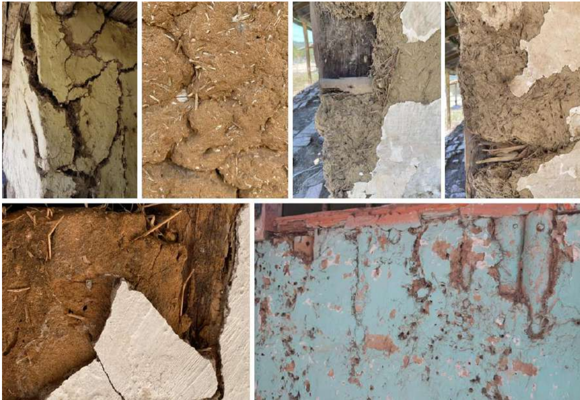
Figura 28. Detalles de los desprendimientos de material de enjarrado.
