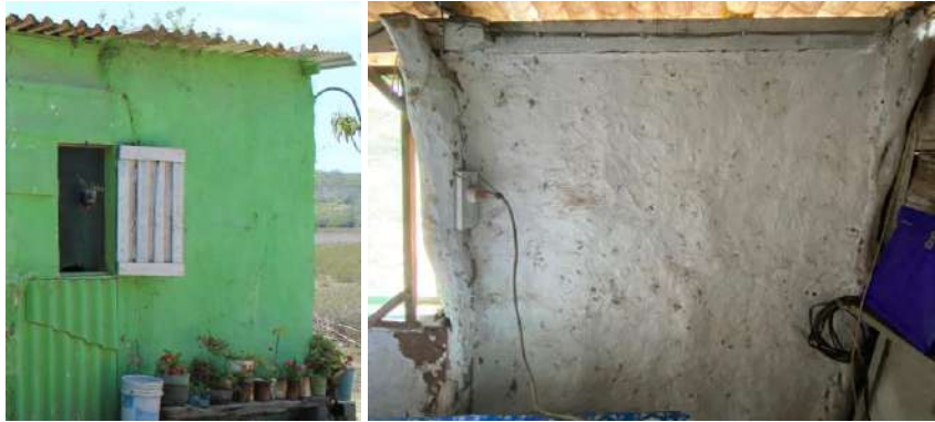
Figura 26. Muros modelo de vivienda de bahareque para estudio térmico.
