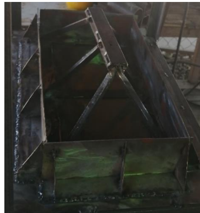
Figura 10. Piezas colocadas como apoyo alrededor del molde. Fuente: Propia del autor (2021).
