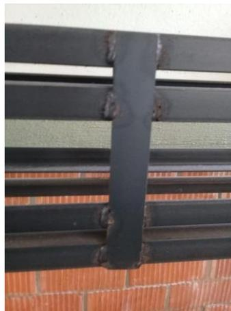
Figura 70. Detalle de ángulos y soleras de los dos marcos.
