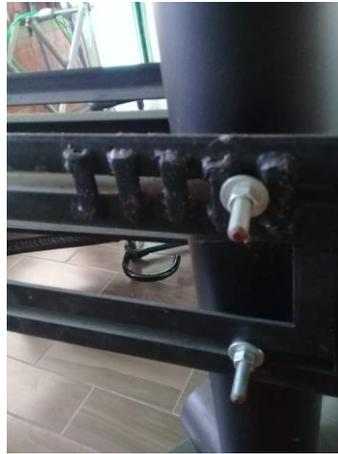
Figura 69. Detalle de conexión entre marcos y postes de apoyo.
