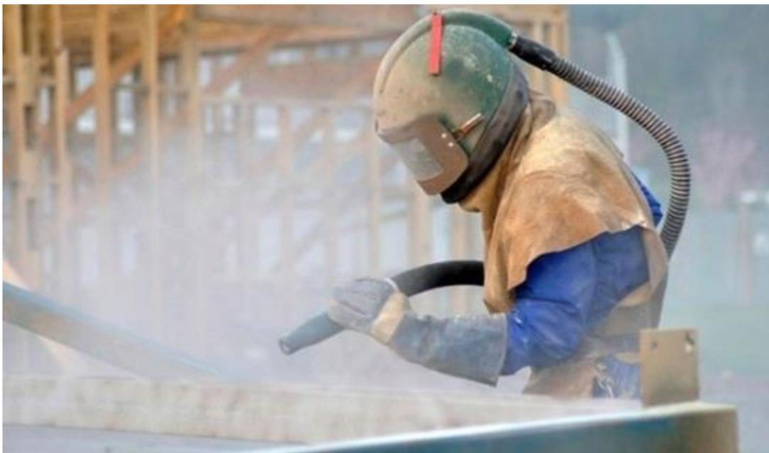
*Figura 1. Sandblasteo. Fuente: ((Sand Blast y Pintura, 2021)*
